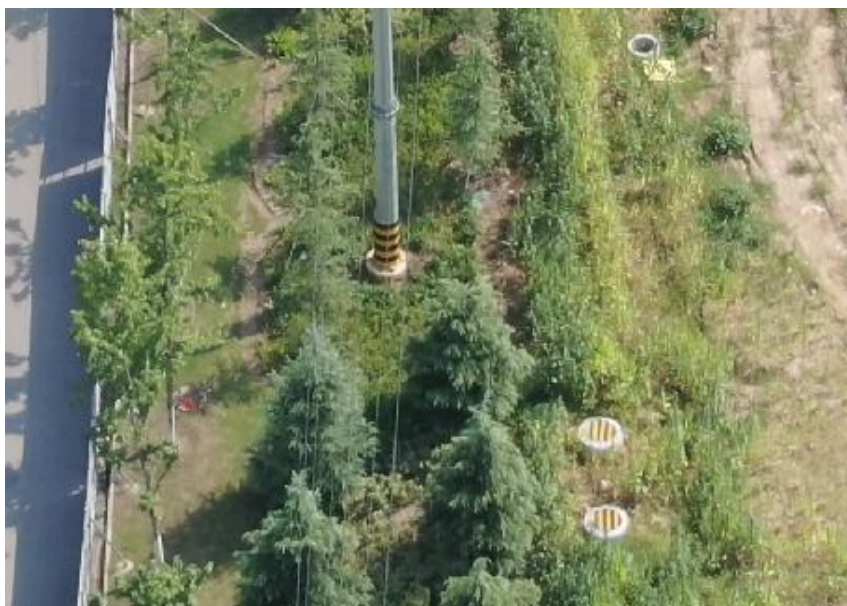
(2) 无人机拍摄图像，2023 年 9 月 1 日，电缆施工区
