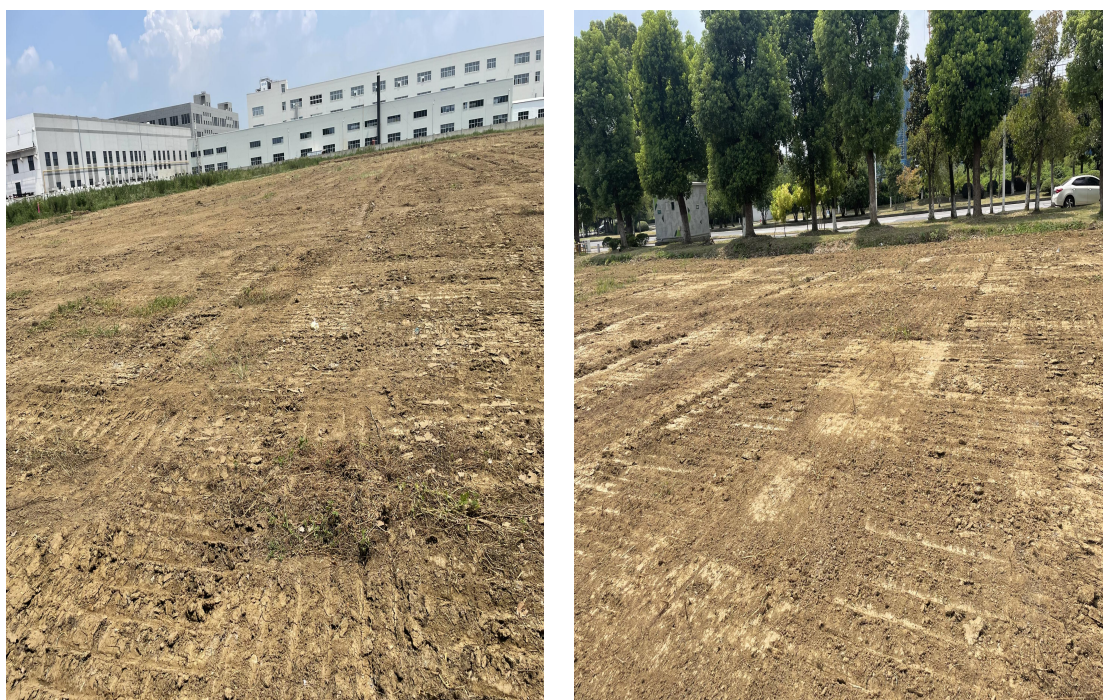
图 1.1-2 本工程现场踏查照片
