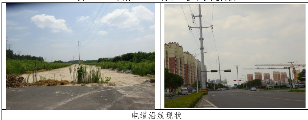
图 1.1-2 本期 110kV 线路工程沿线现状照片
