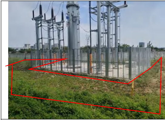
塔基区 撒播草籽 (2023.5)
