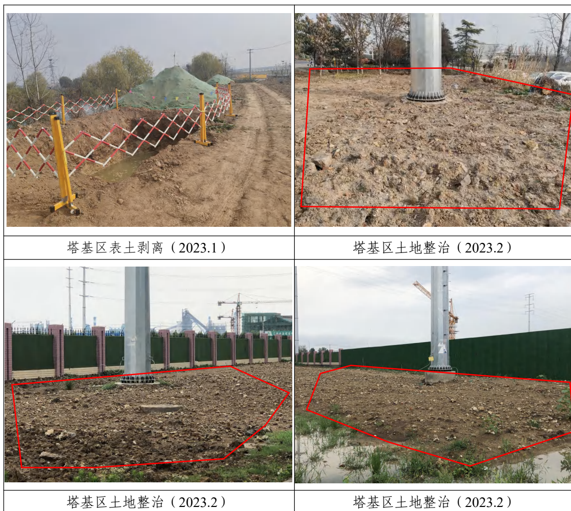
图 4-1 水土保持工程措施实施情况
