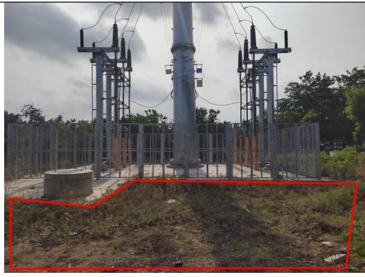
电缆施工区 撒播草籽 (2023.5)
