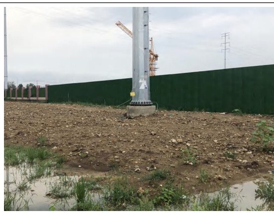
塔基区土地整治（2023.2）
