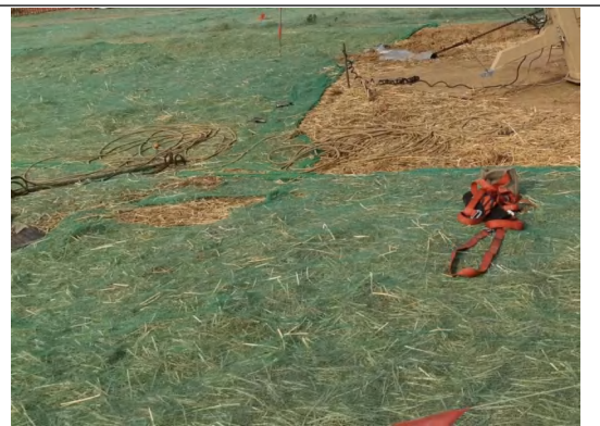
塔基区 密目网苫盖（2023.1）
