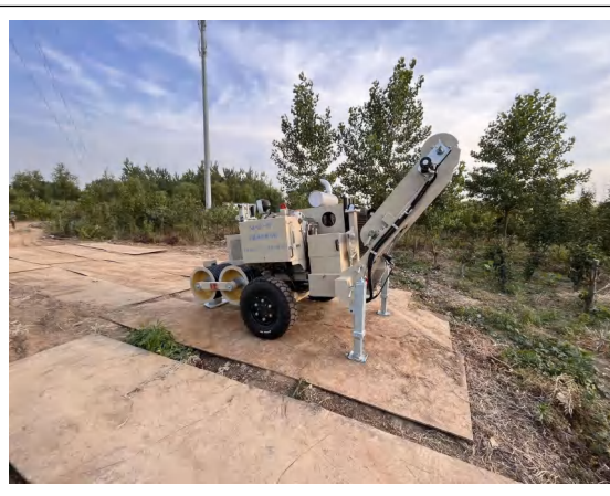
牵张场及跨越场区 铺设钢板（2023.2）
