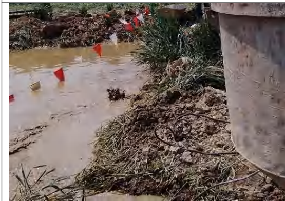
塔基区 泥浆沉淀池（2023.1）
