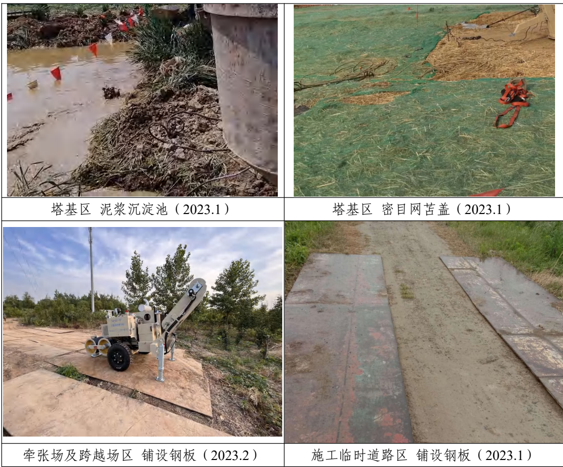
图 4-3 水土保持临时措施实施情况
