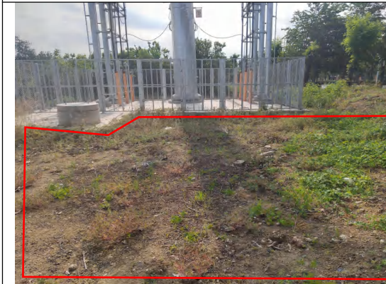
电缆施工区 撒播草籽 (2023.5)
