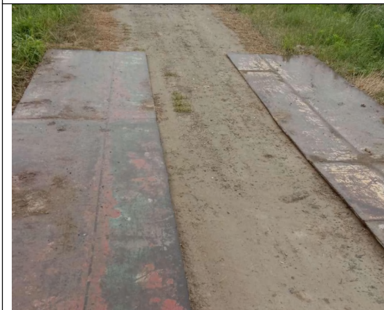
施工临时道路区 铺设钢板（2023.1）
