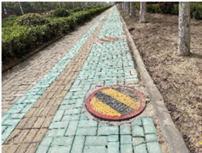
电缆施工区综合绿化和硬化恢复
