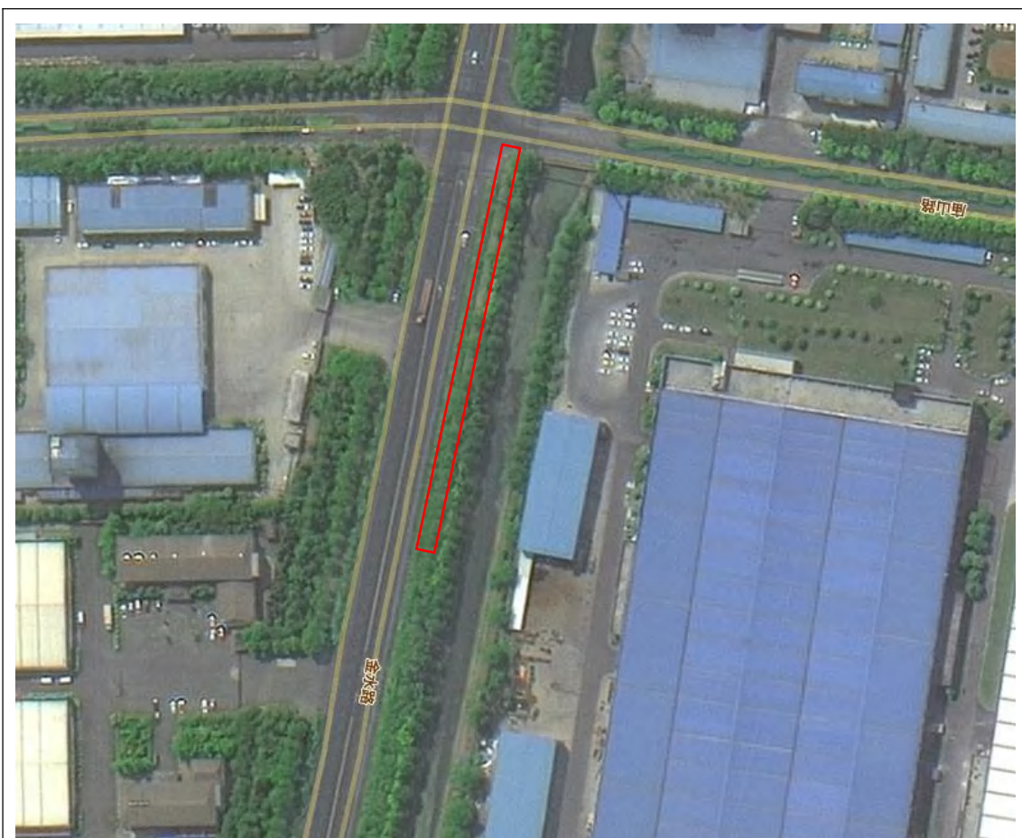
电缆施工区施工前（2020.08）
