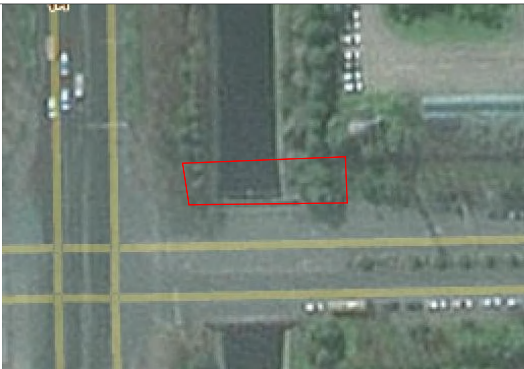
电缆施工区施工前（2022.08）
