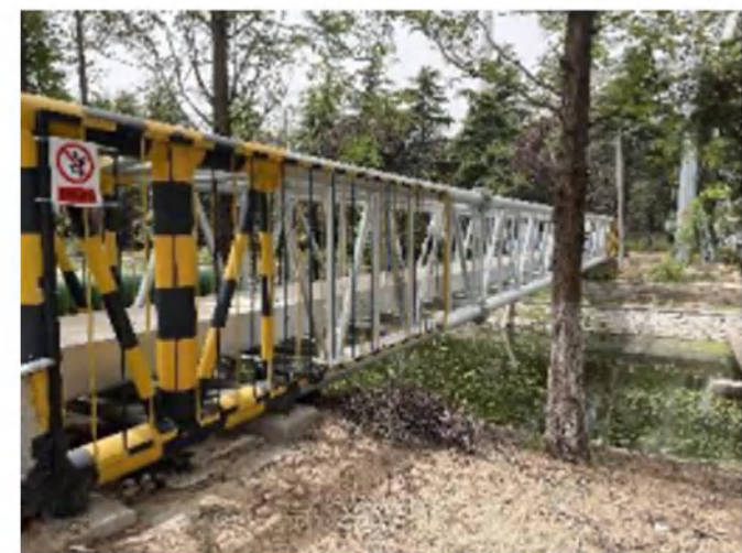
电缆施工区综合绿化恢复
