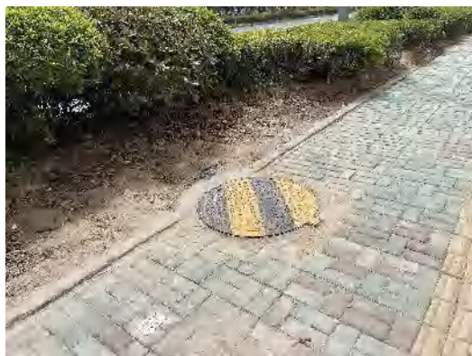
2023 年 5 月 24 日 电缆施工区 恢复硬化、 综合绿化
