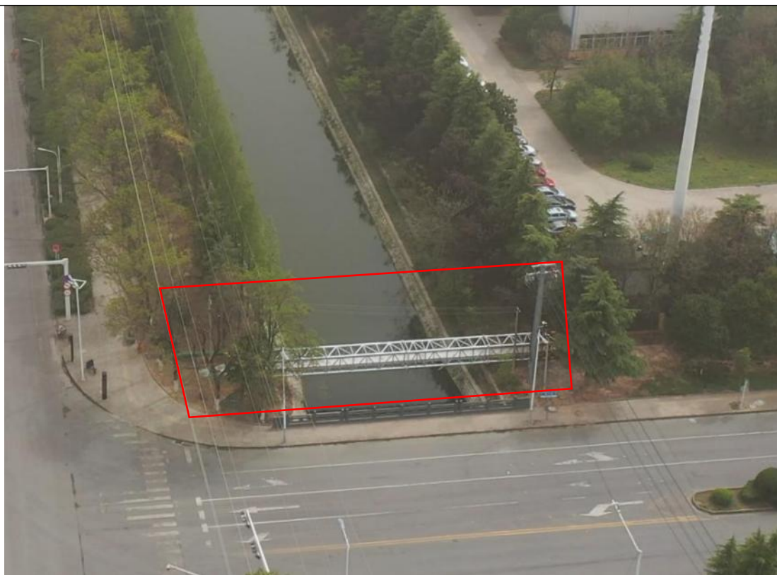
电缆施工区施工后期（2023.05）
