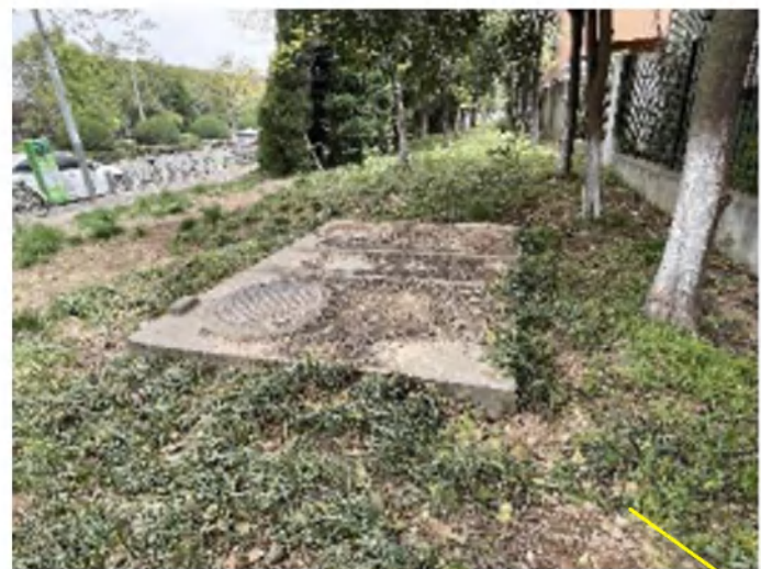
电缆施工区综合绿化恢复
