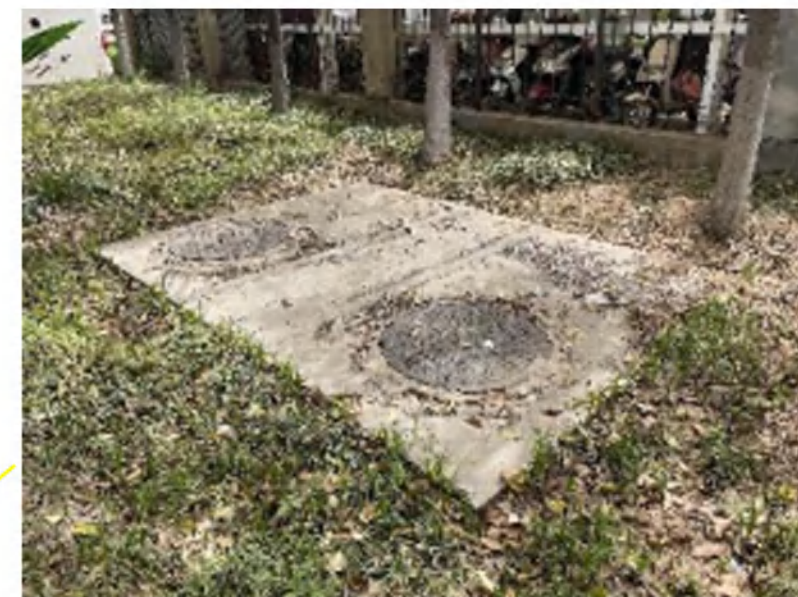
电缆施工区综合绿化恢复
