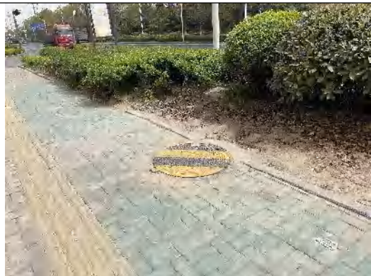
电缆施工区综合绿化 (2023.5)
