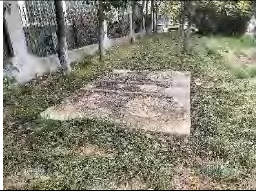
电缆施工区综合绿化 (2023.5)
