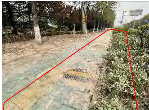
电缆施工区综合绿化 (2023.5)
