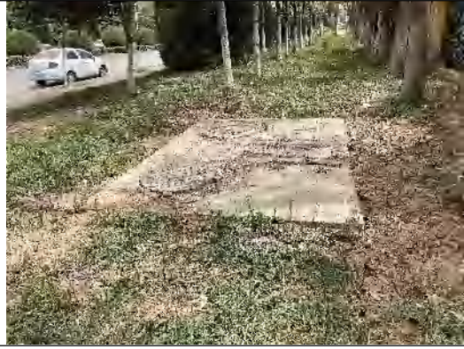
电缆施工区综合绿化 (2023.5)
