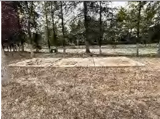
电缆施工区土地整治 (2023.2)
