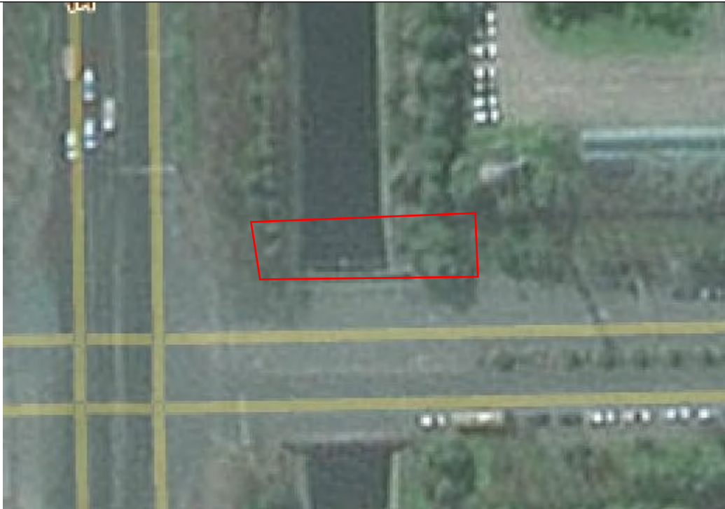
电缆施工区施工前（2022.08）
