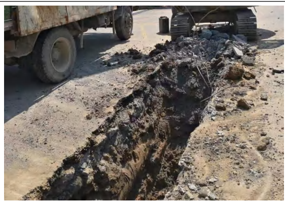
电缆施工区硬化地表拆除（2022.12）
