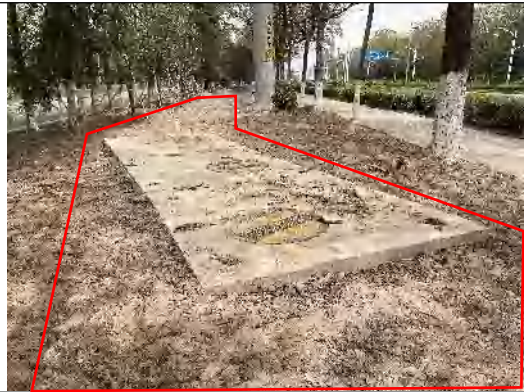
电缆施工区土地整治 (2023.2)
