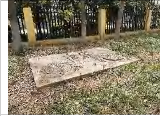
电缆施工区综合绿化 (2023.5)
