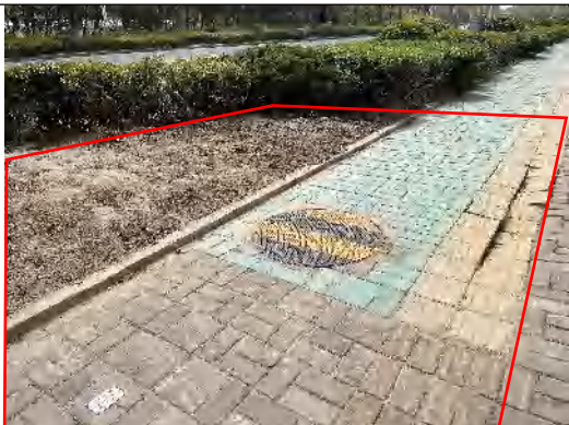
电缆施工区综合绿化 (2023.5)
