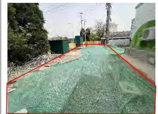
电缆施工区密目网苫盖（2023.01）
