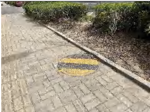
电缆施工区综合绿化 (2023.5)
