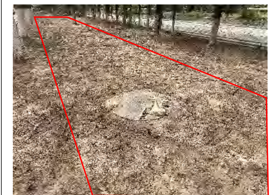
电缆施工区土地整治（2023.2）
