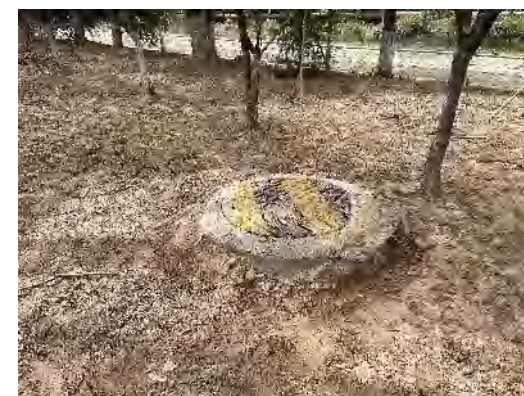
电缆施工区土地整治（2023.2）
