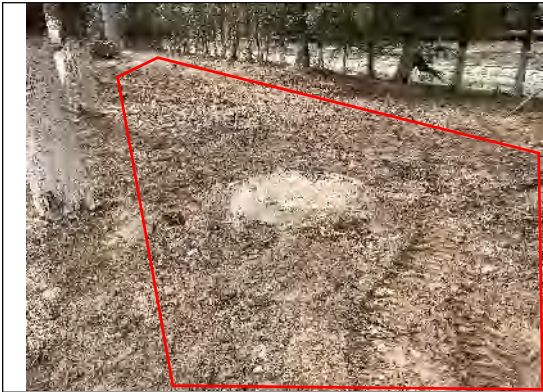
电缆施工区土地整治 (2023.2)
