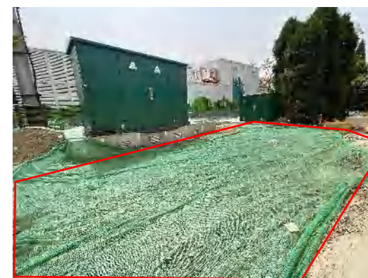
电缆施工区密目网苫盖（2023.01）
