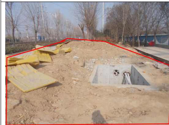
电缆施工区围挡（2022.12）
