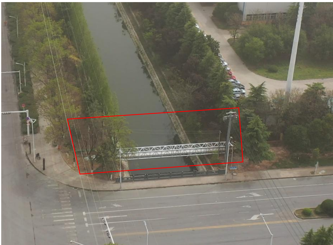
电缆施工区施工后期（2023.05）
