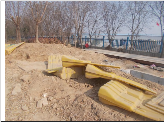
电缆施工区围挡（2022.12）
