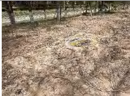
电缆施工区土地整治 (2023.2)
