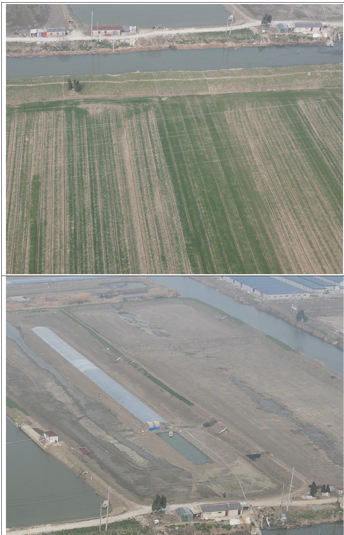
图 1.1-2 本工程现场踏勘照片
