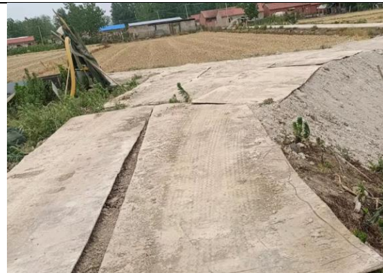
线路塔基区对裸露地表实施苫盖、施工临时道路铺设钢板。
