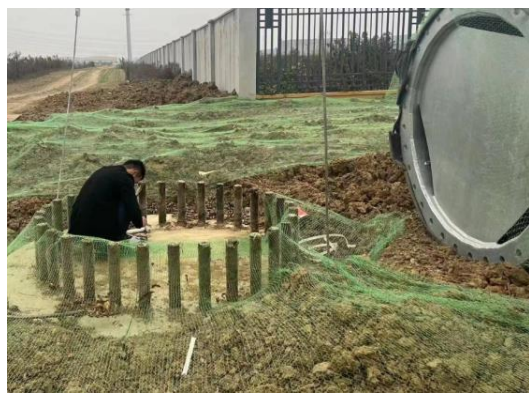
线路塔基区对裸露地表实施苫盖、施工临时道路铺设钢板。
