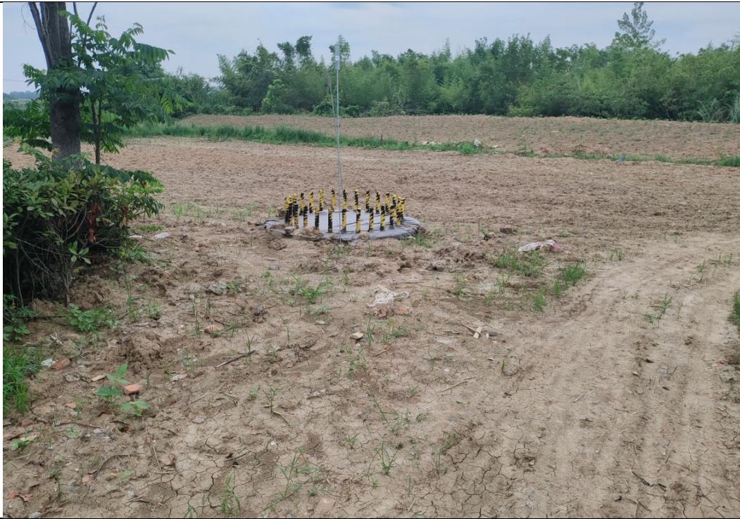
部分线路塔基区对裸露地表未采取临时苫盖措施、施工临时道路未铺设钢板。
