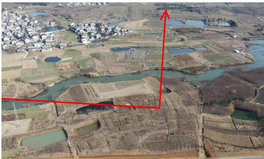
35kV 华大线现状（拆除线路）
