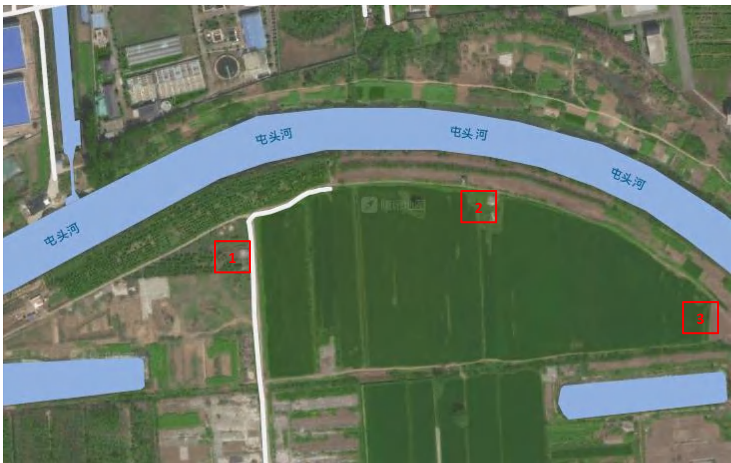
2021 年 4 月 塔基区 施工前期卫星影像
