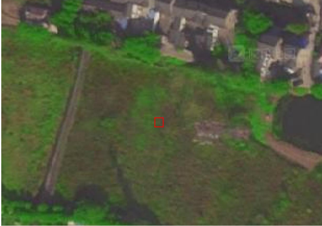
220kV 官上 2935/2936 线 27#塔建设前影像
