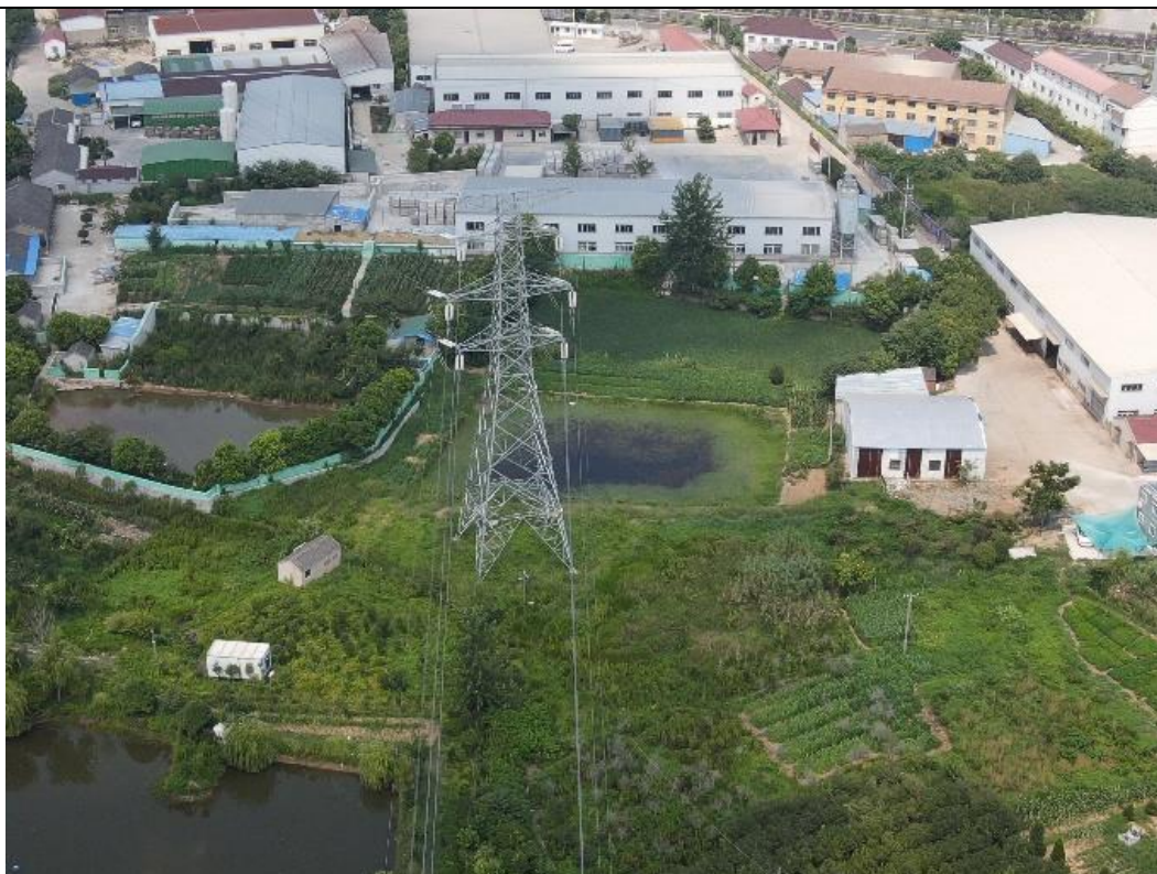
220kV 官上 2935/2936 线 28#塔建设后影像
