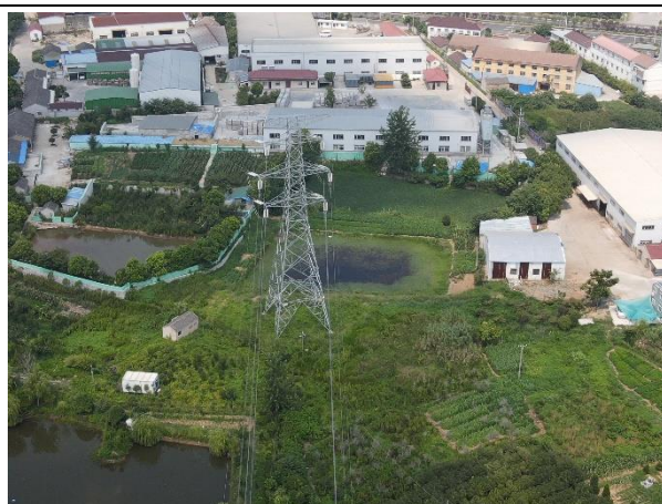
措施名称：220kV 官上 2935/2936 线 28#塔基植被恢复
