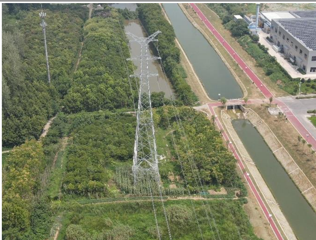
220kV 官上 2935/2936 线 18#塔建设后影像
