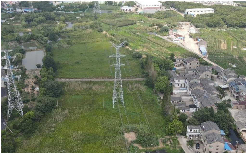
220kV 官上 2935/2936 线 27#塔建设后影像
