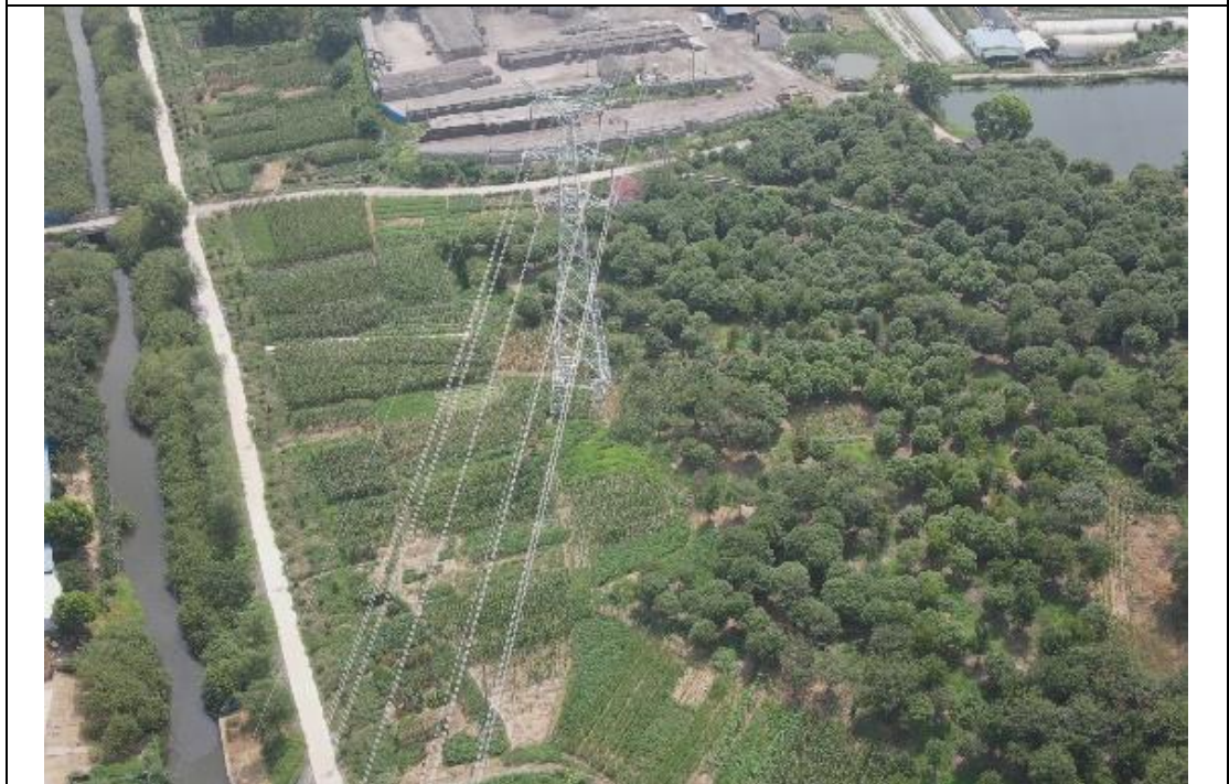
220kV 官上 2935/2936 线 25 塔建设后影像
