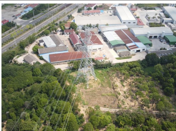
措施名称：220kV 官上 2935/2936 线 29#塔基植被恢复
