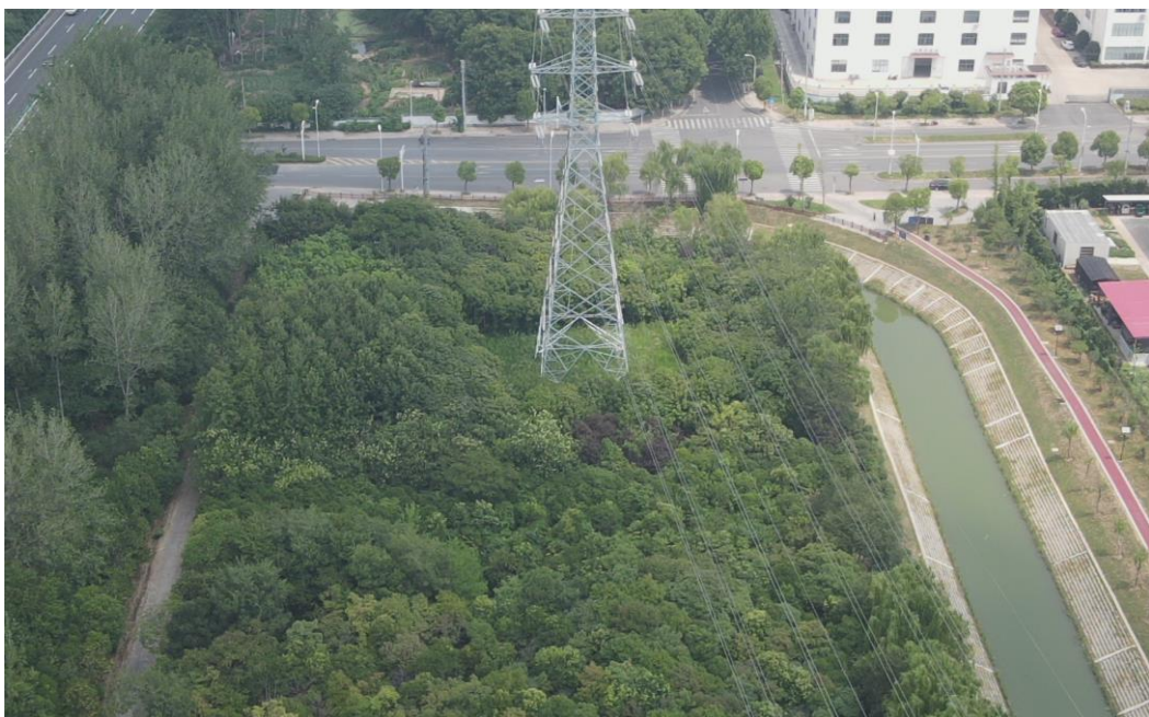
220kV 官上 2935/2936 线 16#塔建设后影像
