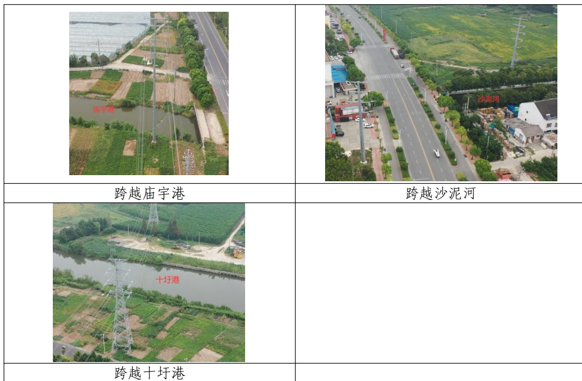
图 1-1 跨越河流塔基现场照片
