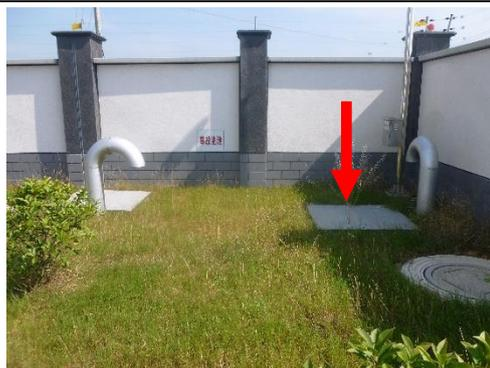
图 6-4 110kV 曹山变事故油池照片
