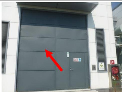
图6-2 110kV曹山变主变室外隔声门照片
