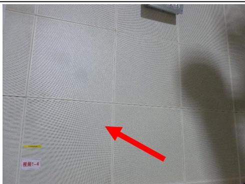
图6-2 110kV曹山变主变室内吸声墙照片
