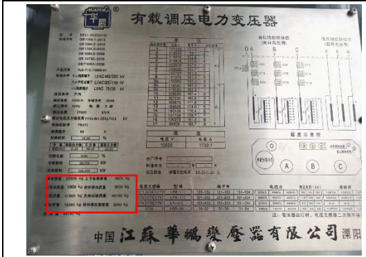
本期 110kV 钱资湖变#1 主变（含油重）铭牌照片
