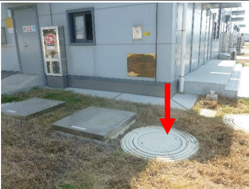
图 8-2 110kV 钱资湖变化粪池照片
