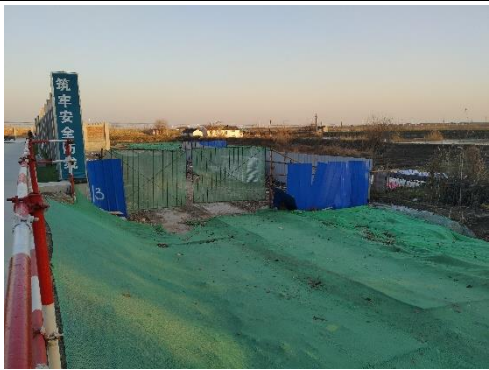
施工期对钱资湖变裸露场地进行覆盖照片
