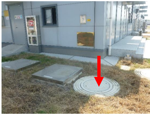
图6-3 110kV钱资湖变化粪池照片
