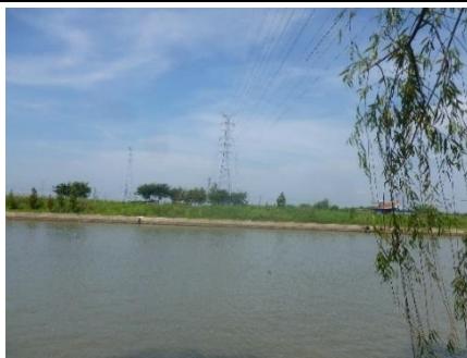
110kV 洮资 7861/洮庄 7848 线#3~#4 杆塔一档跨越丹金溧漕河（金坛区）洪水调蓄区照片
