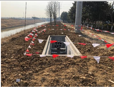
施工期对电缆线路进行围挡建设
