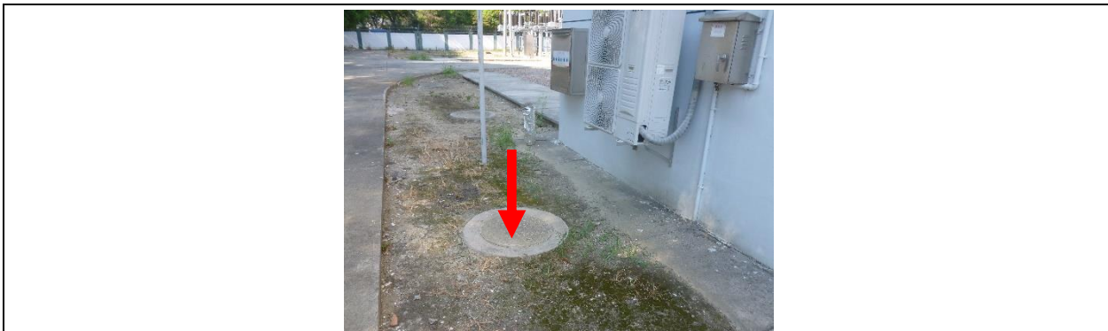
图 8-2 110kV 凤林变化粪池照片
