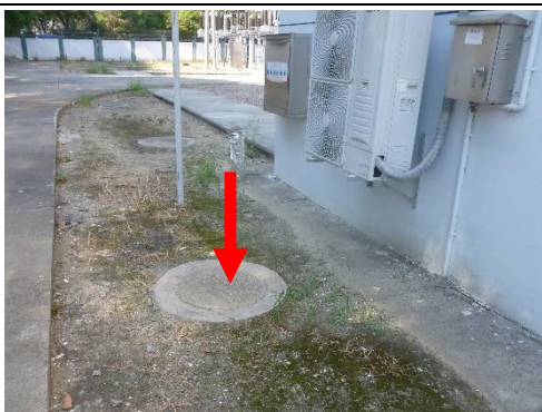
图6-2 110kV凤林变化粪池照片
