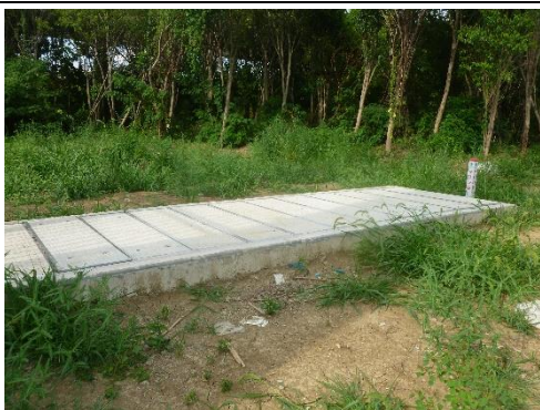
110kV 电缆线路生态恢复照片
