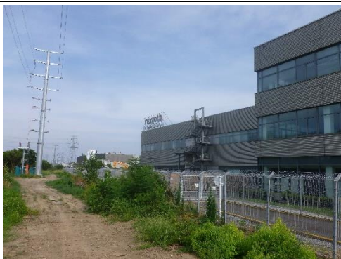
图6-1 本期线路采用同塔双回架设照片
