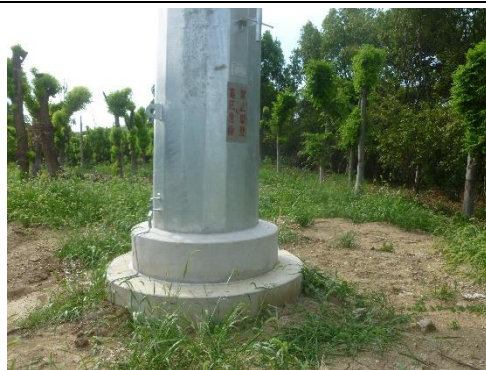
110kV 高湖 7727 线#1 杆塔塔基生态恢复照片
