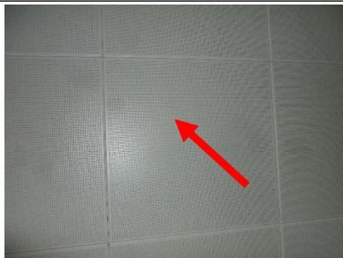
图6-2 110kV剑马变主变室吸声墙照片
