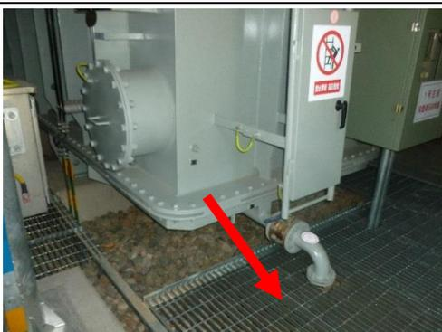
图6-4 110kV剑马变主变下方事故油坑照片
