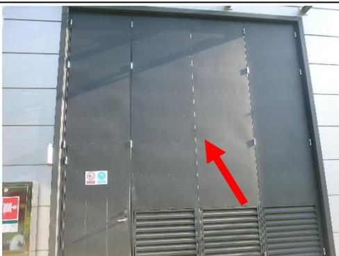
图6-2 110kV剑马变主变室外隔声门照片
