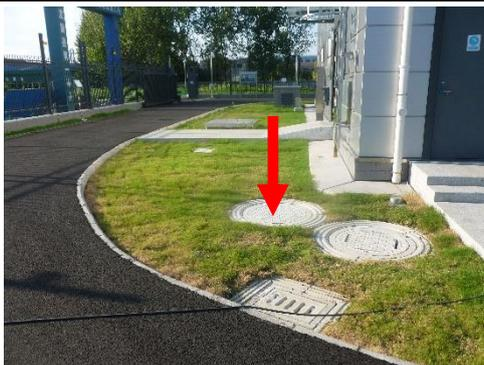
图 8-3 110kV 剑马变化粪池照片
