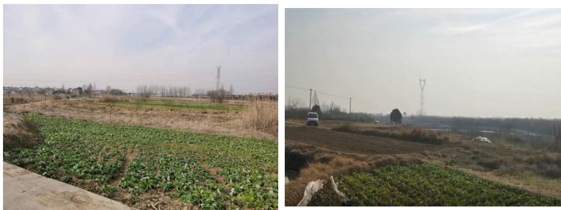
变电所现场图
