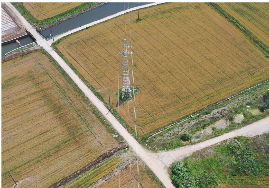
塔基 T14 项目施工后 2022.5
