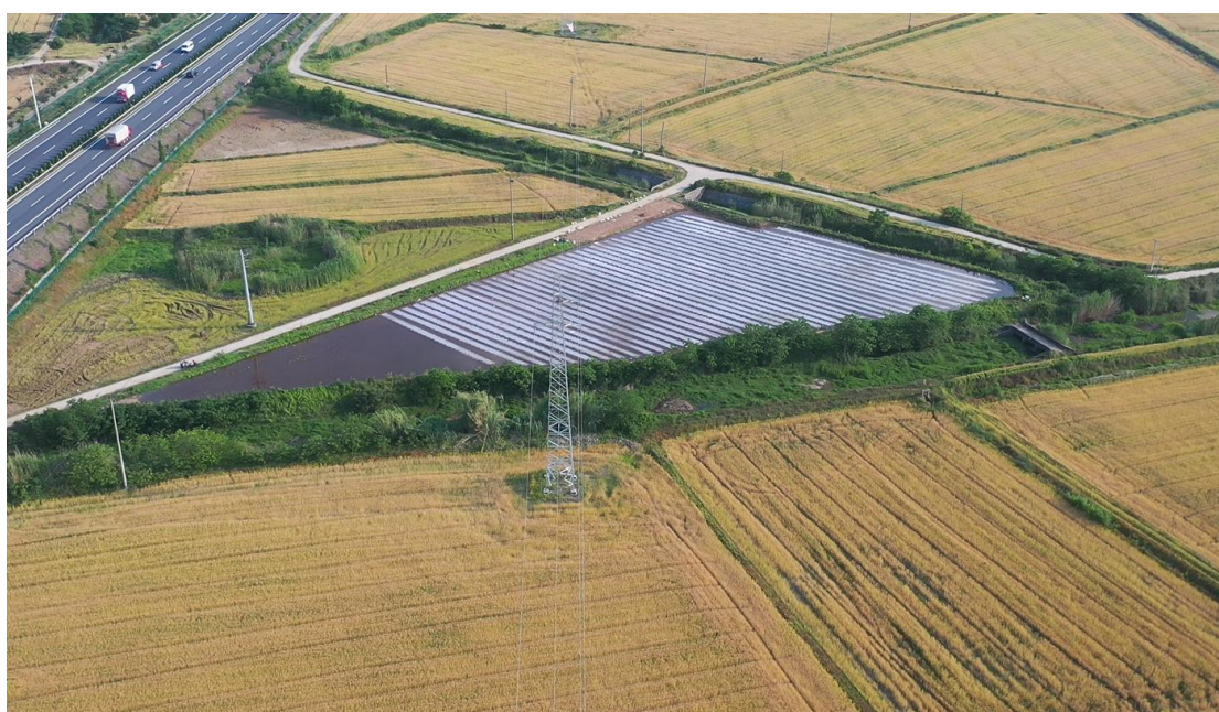
塔基 T16 项目施工后 2022.5
