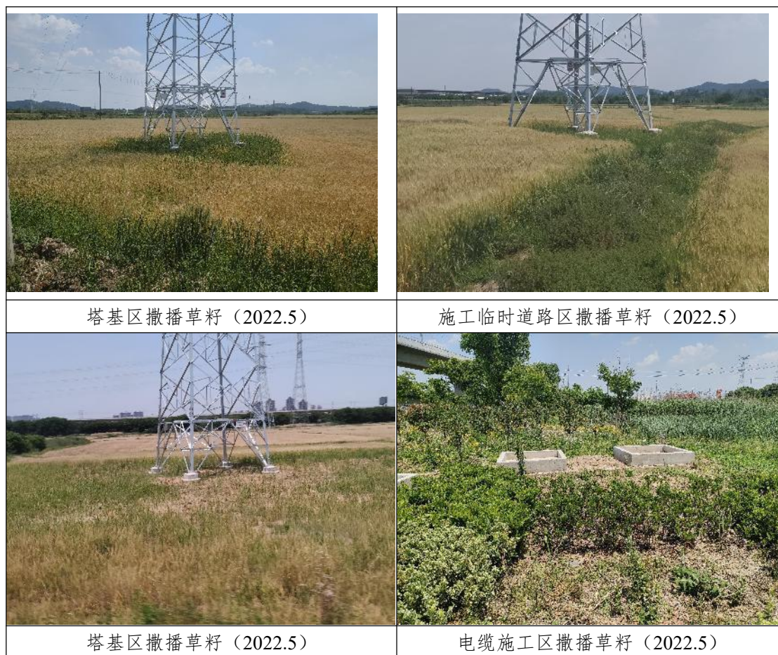
图 4-2 水土保持植物措施实施情况
