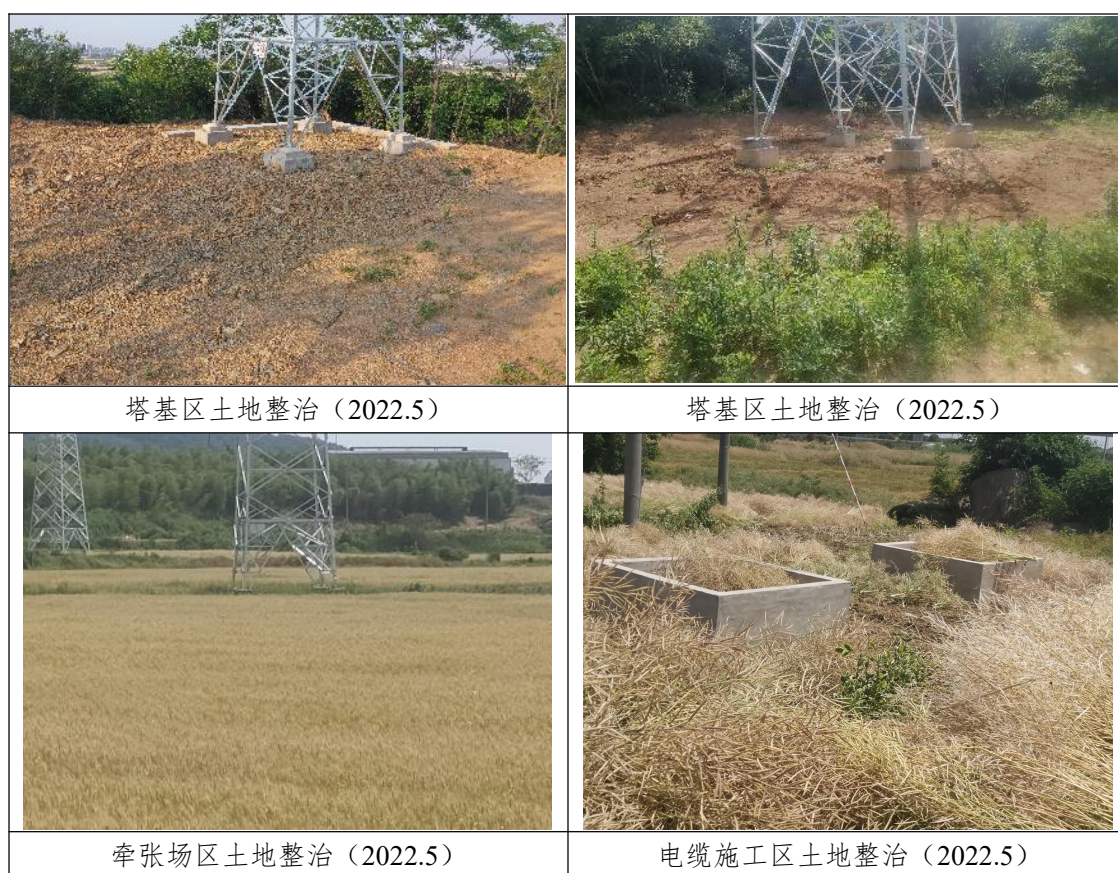
图 4-1 水土保持工程措施实施情况
