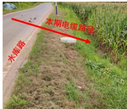
电缆路径过水库路（开挖）
