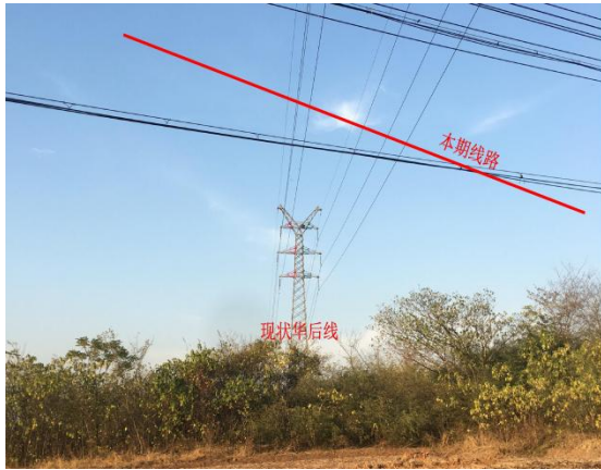
跨越 110kV 华后 757 线现场图
