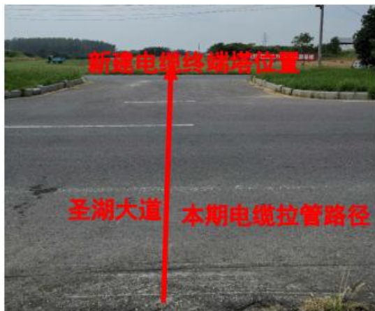
电缆路径过圣湖大道（电缆拉管敷设）
