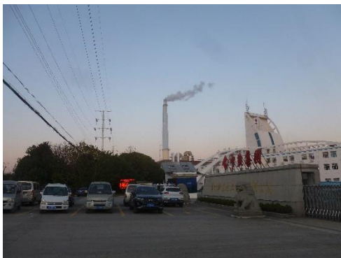
图6-1 本工程同塔多回架空线路
