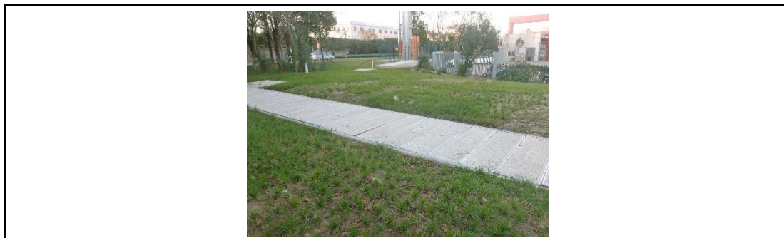
110kV 电缆线路周围生态恢复照片
