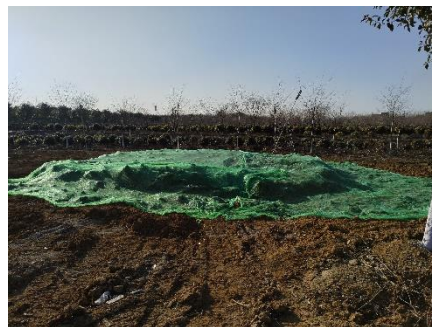
图6-2 施工现场塔基基础周围进行苫盖
