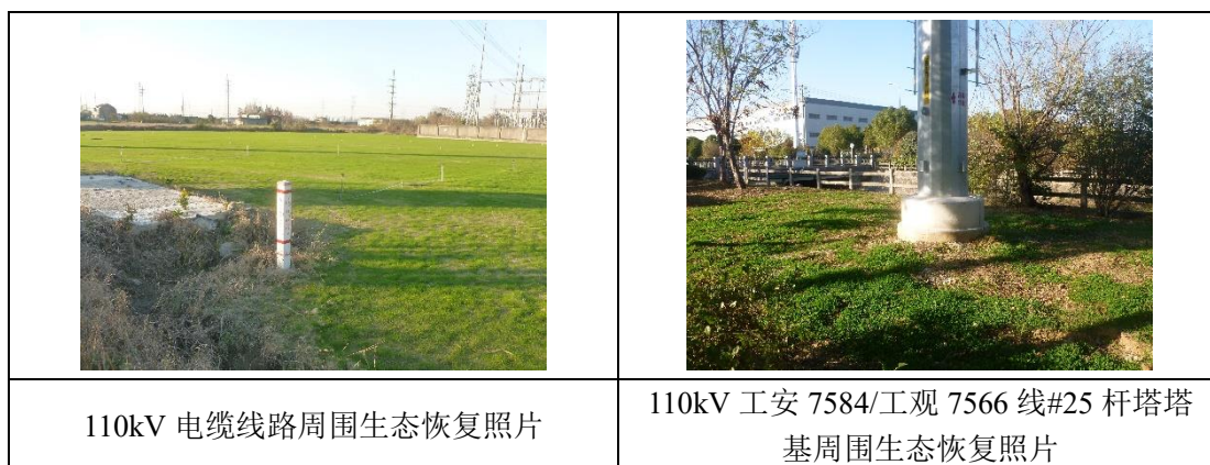
图 8-2 本工程生态恢复示例照片
