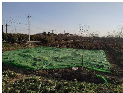
图6-2 施工现场塔基基础周围进行苫盖
