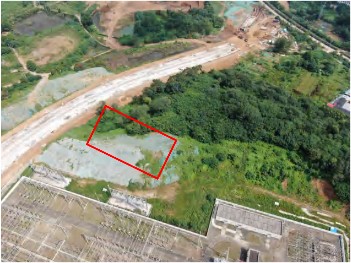
新建珠泉 110kV 变电站站址位置
