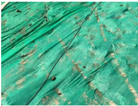
图 8-1 施工期设置覆盖照片
