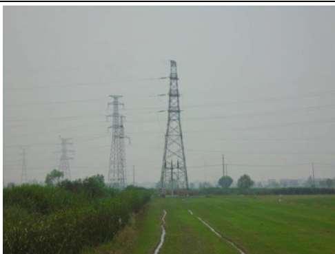
110kV 厉穆 897 线机场支线#1 电缆终端塔 塔基周围照片
