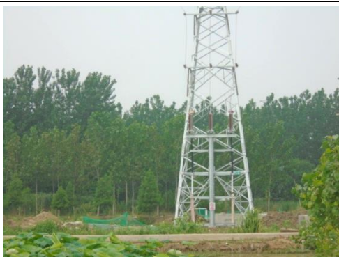
110kV 庄盐 866 线机场支线#9 电缆终端塔 塔基周围照片
