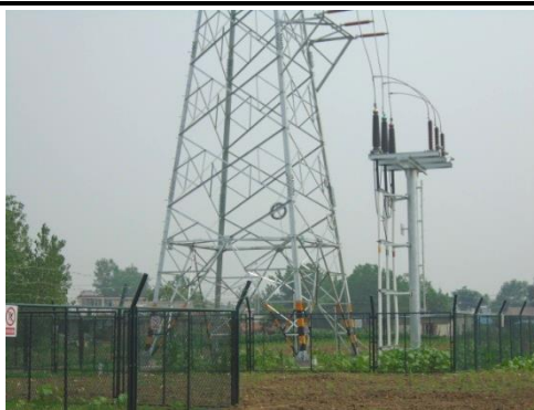
110kV 庄盐 866 线机场支线#28 电缆终端塔塔基周围照片
