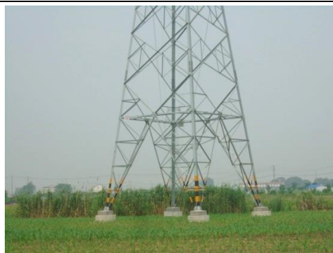
110kV 厉穆 897 线机场支线#19 杆塔塔基周围照片
