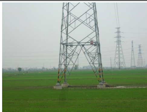
110kV 厉穆 897 线机场支线#6 杆塔塔基周围照片
