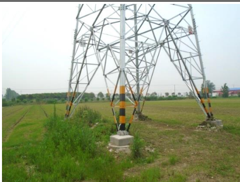
110kV 厉穆 897 线机场支线#12 杆塔塔基周围照片
