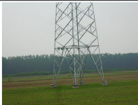
110kV 庄盐 866 线机场支线#11 杆塔塔基周围照片
