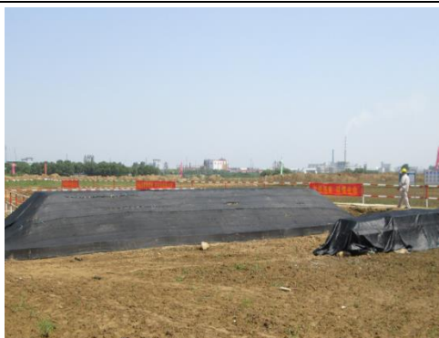
图 8-1 施工期设置覆盖等环保措施照片
