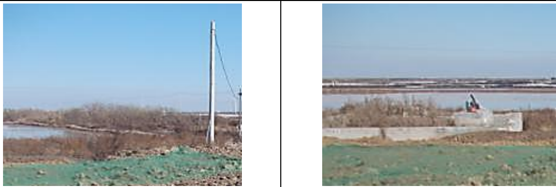
图 8-1 本工程施工期对空地设置密目网覆盖照片
