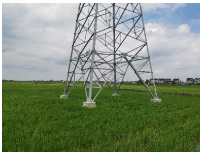
110kV 黄刁 72F 线 15#塔基恢复生态
