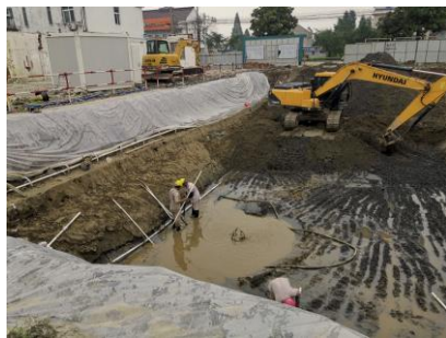
施工期站区苫布苫盖
