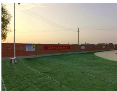
施工期站区密目网覆盖
