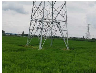
110kV 新钱线刁网支 947 线 48#塔基
