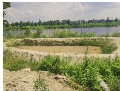
施工期设置泥浆沉淀池
