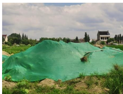
电缆施工期密目网覆盖
