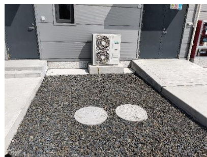
110kV 刁网变站内化粪池
