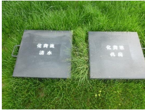
110kV 别桥变站内化粪池
