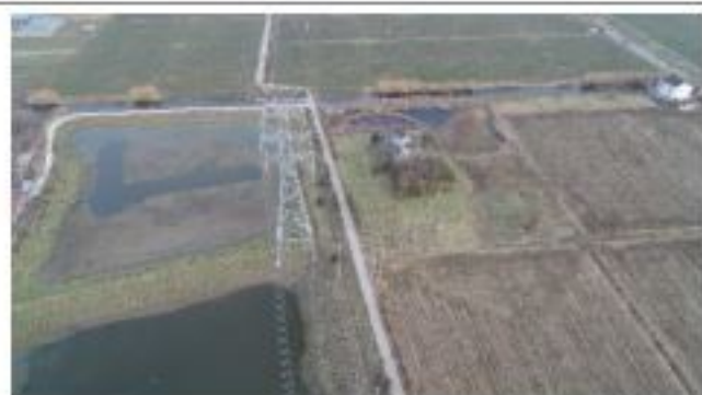
措施名称: 220kV 衡牵 46X4 线 63#塔基复耕
