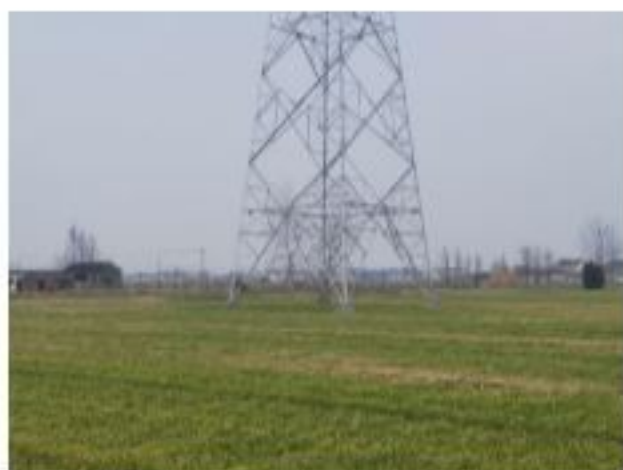
措施名称: 220kV 金牵 46X3/金衡 46X5 线 45#塔基复耕
