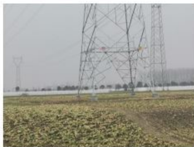
220kV 金牵 46X3/金衡 46X5 线 6#塔基复耕
