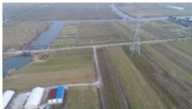
措施名称: 220kV 衡牵 46X4 线 16#塔基复耕
