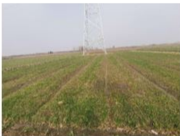
措施名称: 临时施工道路复耕
