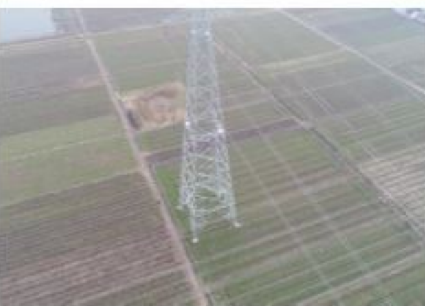
措施名称: 220kV 金牵 46X3/金衡 46X5 线 56#塔基复耕
