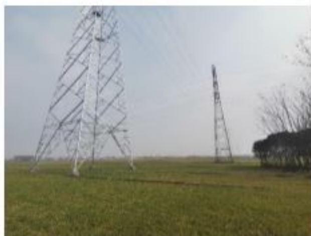
措施名称: 跨越区 (跨越 110kV 线路) 复耕
