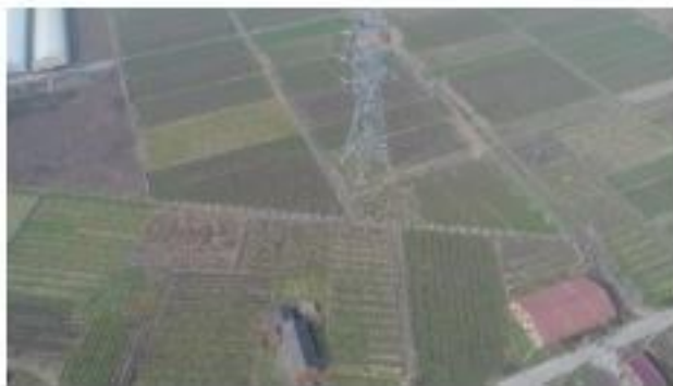
措施名称: 220kV 金牵 46X3/金衡 46X5 线 57#塔基复耕
