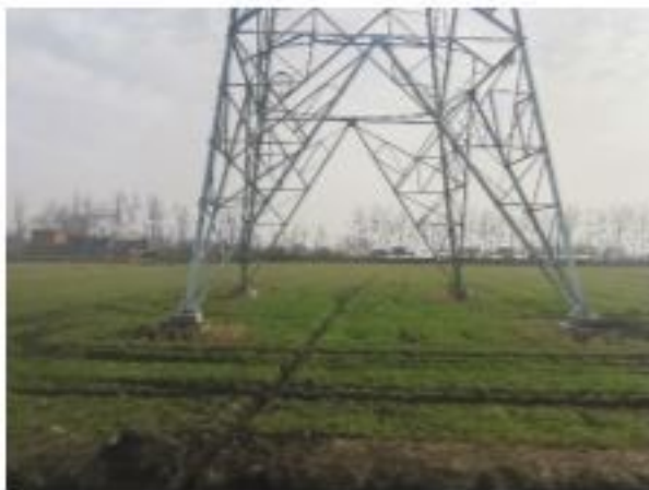
措施名称: 220kV 衡牵 46X4 线 10#塔基复耕
