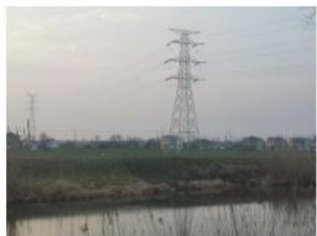
措施名称: 220kV 衡牵 46X4 线 66#塔基复耕
