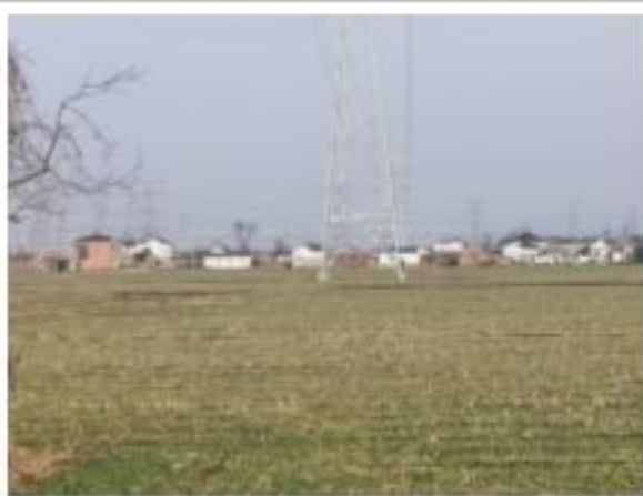
措施名称: 220kV 衡牵 46X4 线 40#塔基复耕
