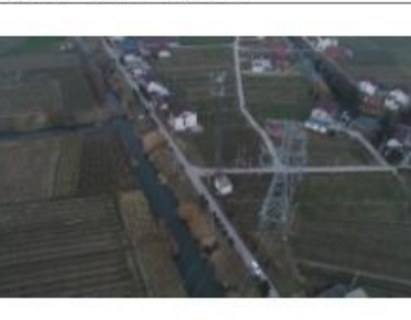
措施名称: 220kV 衡牵 46X4 线 79#塔基复耕
