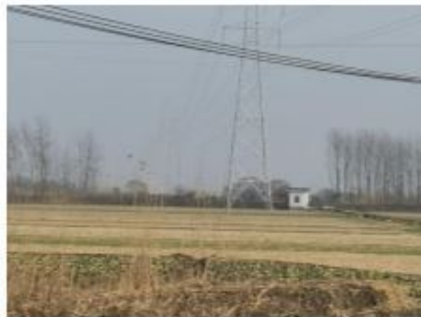
措施名称: 220kV 衡牵 46X4 线 11#塔基复耕
