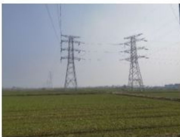
措施名称: 220kV 金牵 46X3 线 68#塔基复耕
