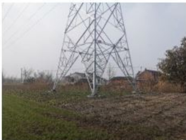
施名称: 220kV 金牵 46X3/金衡 46X5 线 33#塔基复耕
