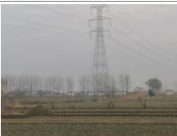
措施名称: 220kV 衡牵 46X4 线 75#塔基复耕
