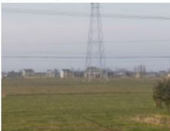
措施名称: 220kV 衡牵 46X4 线 51#塔基复耕
