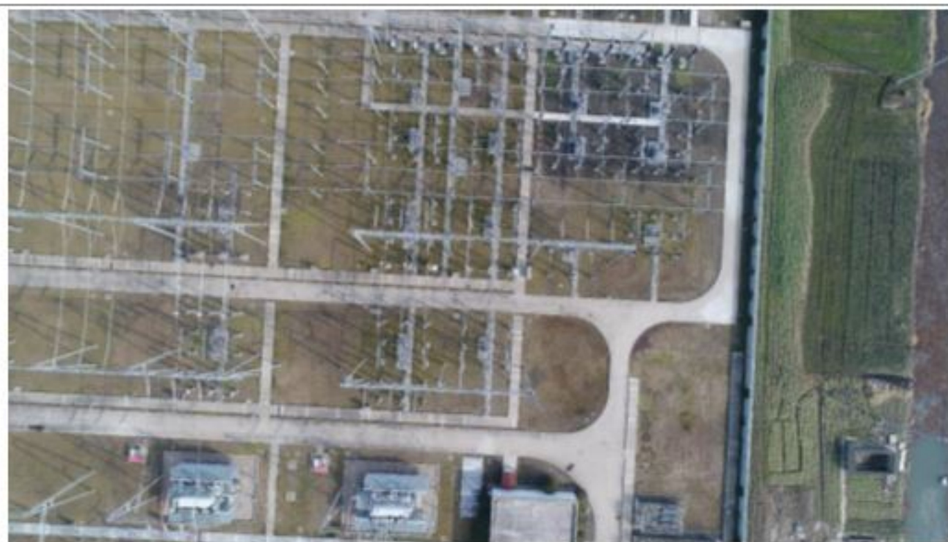
220kV 衡埠变间隔扩建建设后航拍影像图
