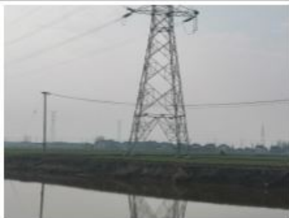
措施名称: 220kV 衡牵 46X4 线 31#塔基复耕
