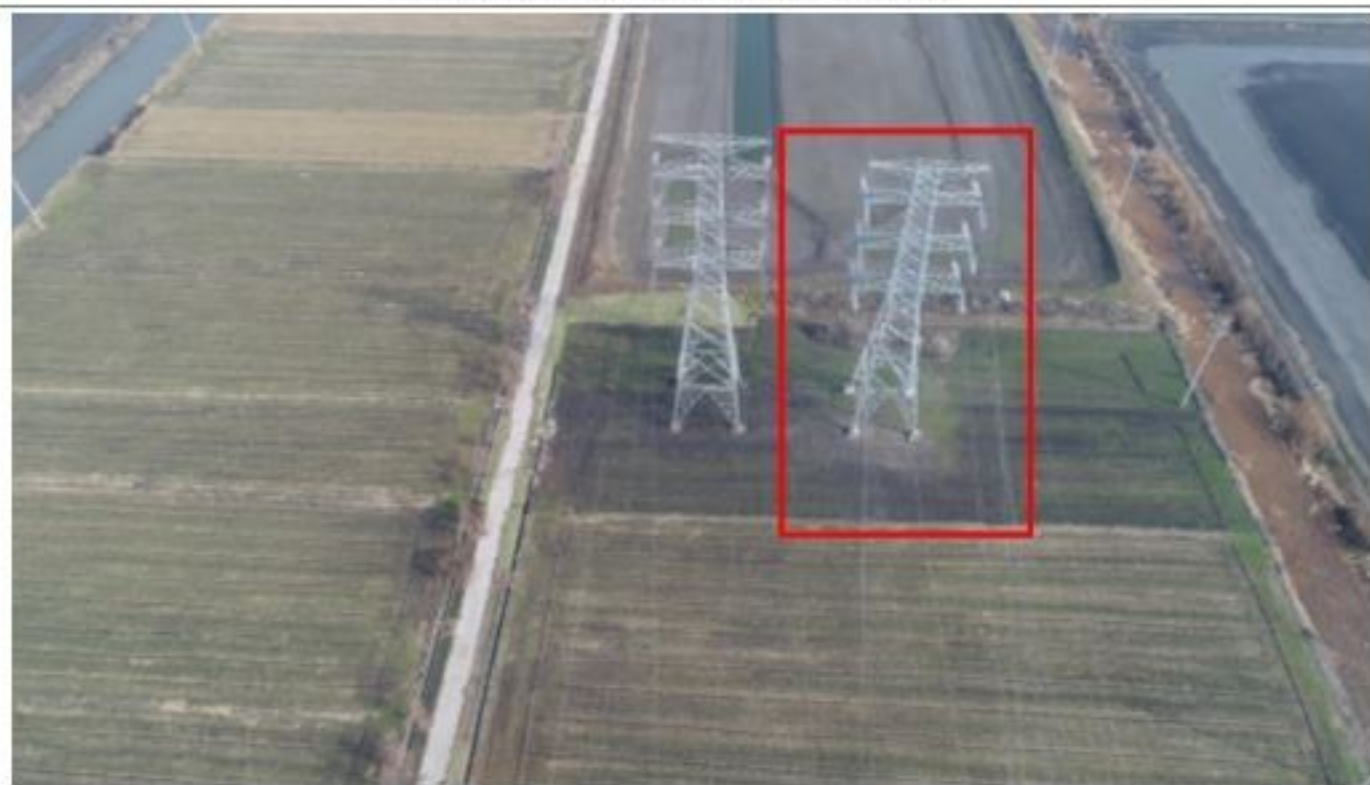
220kV 衡牵 46X4 线 1#塔基建设后航拍影像图
