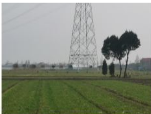
措施名称: 220kV 金牵 46X3/金衡 46X5 线 37#塔基复耕
