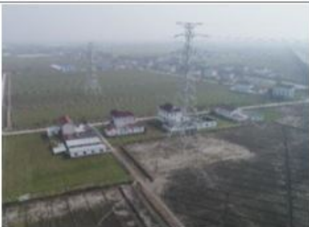
措施名称: 220kV 衡牵 46X4 线 89#、90#塔基复耕
