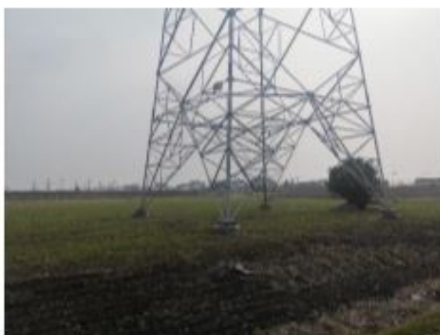
措施名称: 220kV 金牵 46X3/金衡 46X5 线 22#塔基复耕
