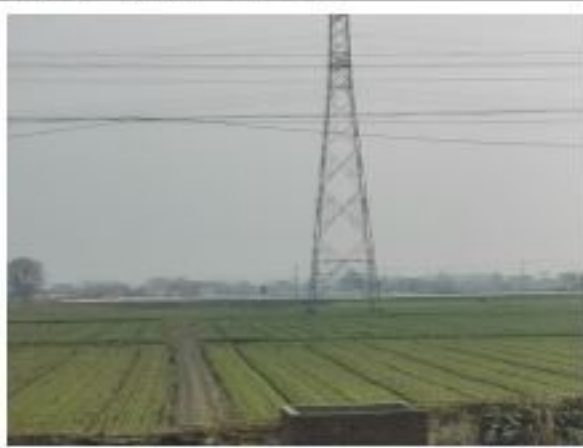
措施名称: 220kV 衡牵 46X4 线 37#塔基复耕
