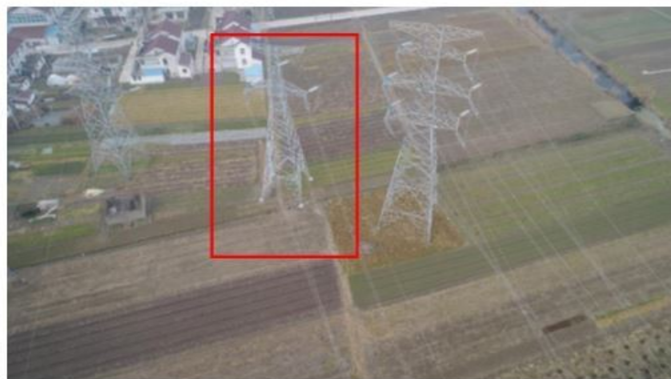
220kV 金衡 46X5 线 1#塔建设后航拍影像图
