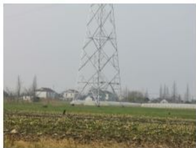
措施名称: 220kV 金牵 46X3/金衡 46X5 线 24#塔基复耕
