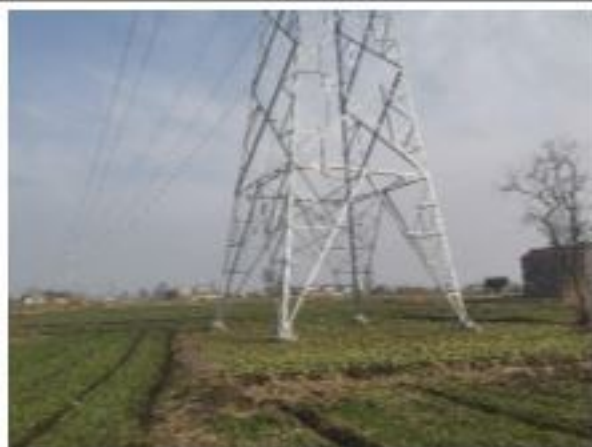
措施名称: 220kV 衡牵 46X4 线 38#塔基复耕
