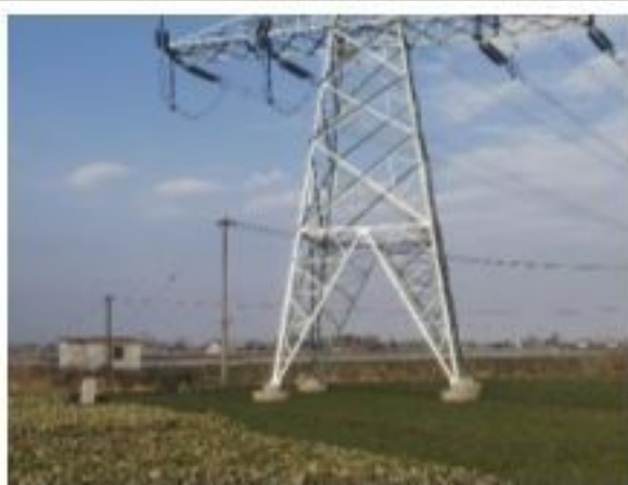
措施名称: 220kV 衡牵 46X4 线 44#塔基复耕
