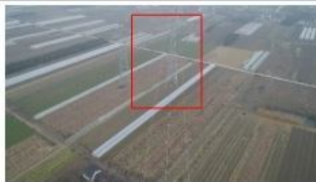
措施名称: 220kV 金衡 46X5 线 3#塔基复耕
