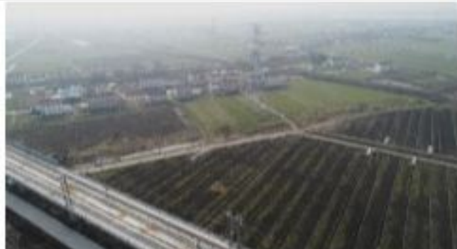
措施名称: 220kV 衡牵 46X4 线 88#塔基复耕
