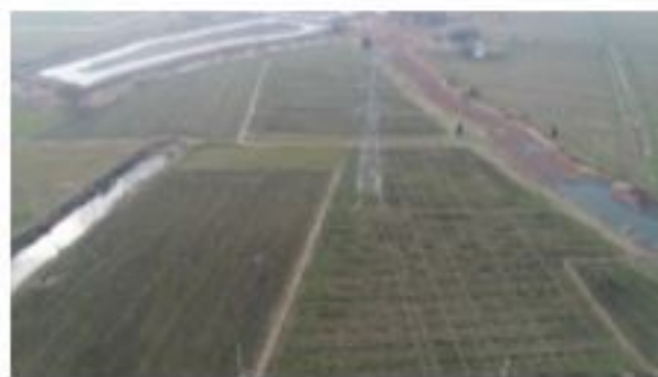
措施名称: 220kV 衡牵 46X4 线 18#塔基复耕
