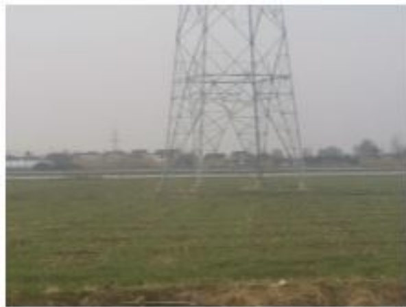
措施名称: 220kV 衡牵 46X4 线 55#塔基复耕
