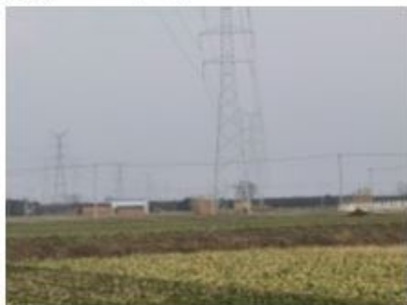
措施名称: 220kV 衡牵 46X4 线 33#塔基复耕
