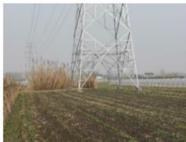
措施名称: 220kV 金牵 46X3/金衡 46X5 线 26#塔基复耕
