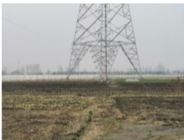
措施名称: 220kV 金牵 46X3/金衡 46X5 线 12#塔基复耕
