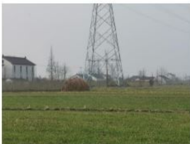
施名称: 220kV 金牵 46X3/金衡 46X5 线 38#塔基复耕
