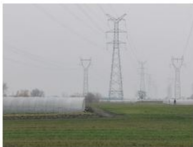
220kV 金牵 46X3/金衡 46X5 线 8#塔基复耕
