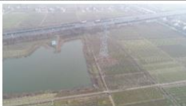
措施名称: 220kV 金牵 46X3/金衡 46X5 线 55#塔基复耕
