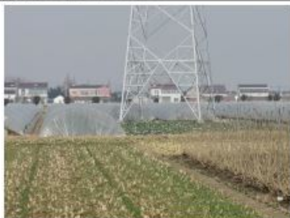
220kV 金牵 46X3/金衡 46X5 线 61#塔基复耕
