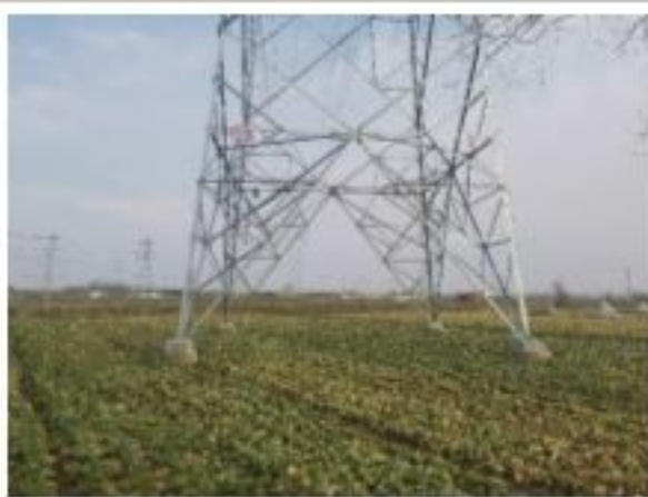
措施名称: 220kV 衡牵 46X4 线 32#塔基复耕
