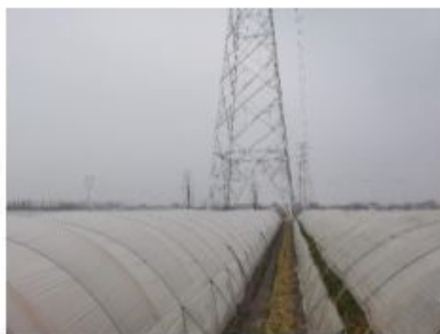
措施名称: 220kV 金牵 46X3/金衡 46X5 线 13#塔基复耕
