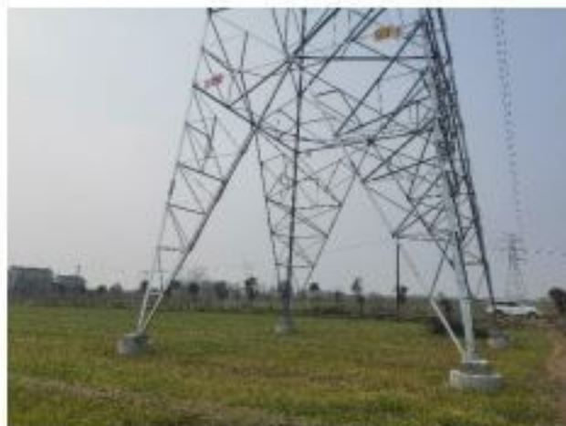
措施名称: 220kV 金牵 46X3/金衡 46X5 线 52#塔基复耕
