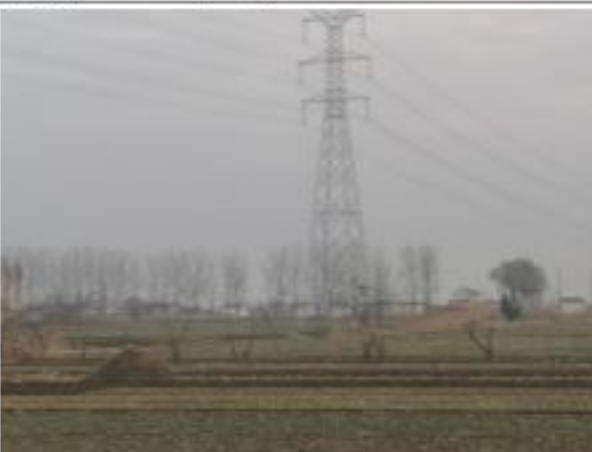
措施名称: 220kV 衡牵 46X4 线 75#塔基复耕
