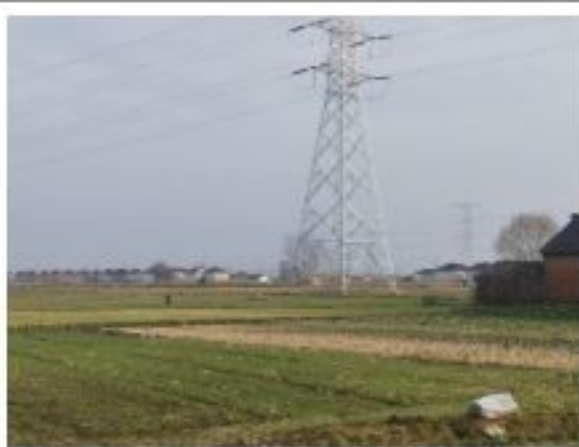
措施名称: 220kV 衡牵 46X4 线 47#塔基复耕
