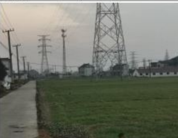
措施名称: 220kV 衡牵 46X4 线 80#塔基复耕
