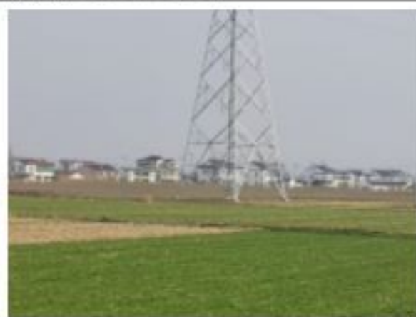
220kV 金牵 46X3/金衡 46X5 线 67#塔基复耕
