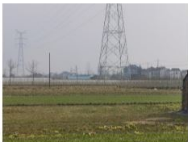
措施名称: 220kV 金牵 46X3/金衡 46X5 线 44#塔基复耕
