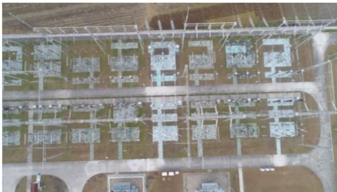
220kV 金东变间隔扩建区建设后航拍影像图
