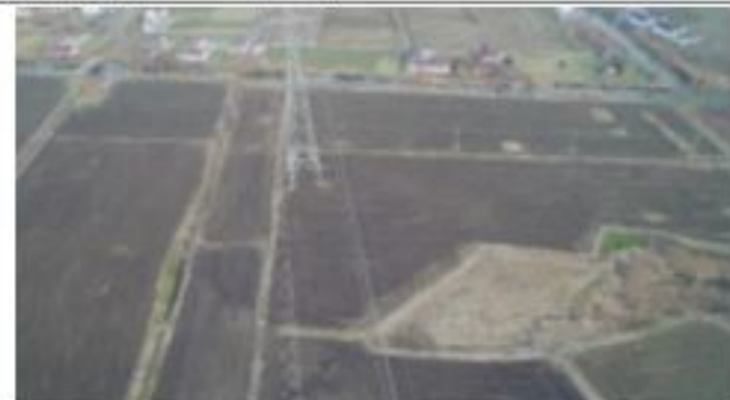
措施名称: 220kV 衡牵 46X4 线 62#塔基复耕
