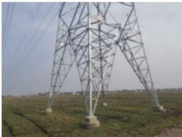
措施名称: 220kV 衡牵 46X4 线 16#塔基复耕
