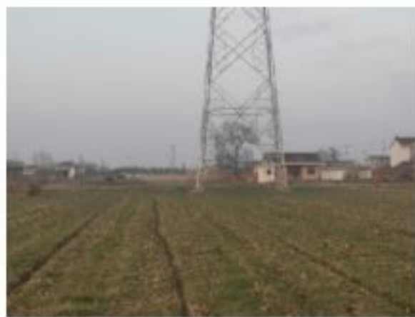
措施名称: 220kV 衡牵 46X4 线 74#塔基复耕
