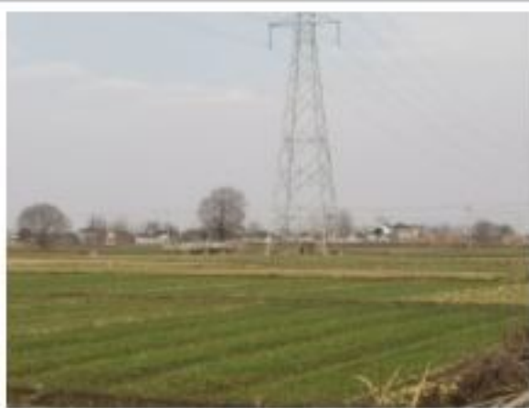
措施名称: 220kV 衡牵 46X4 线 49#塔基复耕
