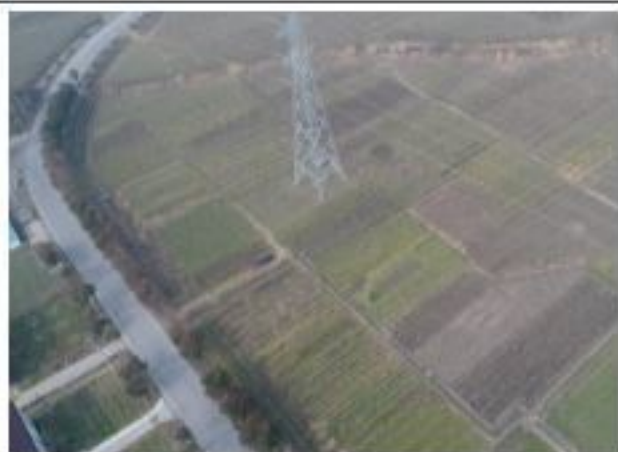
220kV 金牵 46X3/金衡 46X5 线 59#塔基复耕
