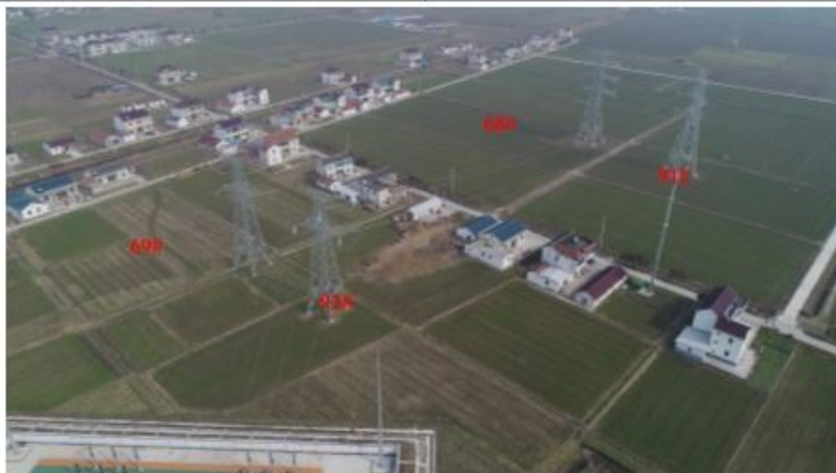
措施名称: 220kV 衡牵 46X4 线 91#、92#塔基、220kV 金牵 46X3 线 68#、69#塔基复耕
