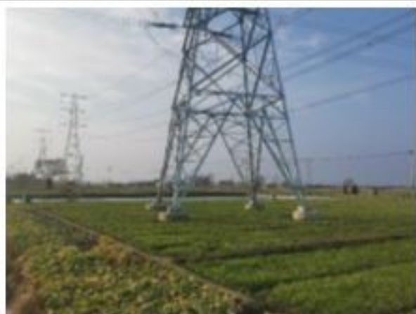
措施名称: 220kV 衡牵 46X4 线 43#塔基复耕
