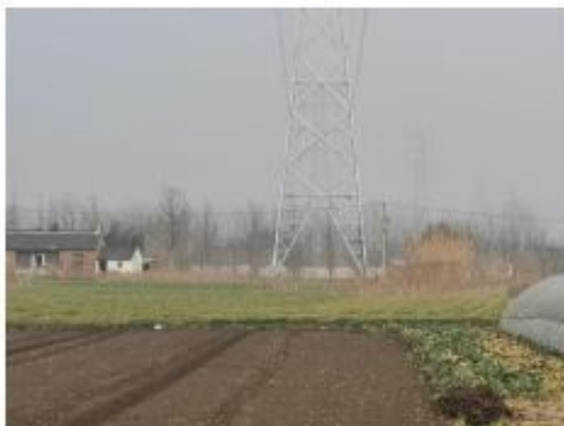
措施名称: 220kV 金牵 46X3/金衡 46X5 线 18#塔基植被恢复及复耕
