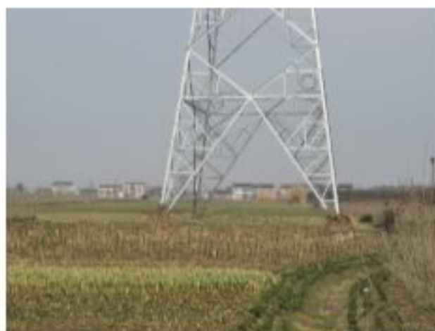
措施名称: 220kV 金牵 46X3/金衡 46X5 线 49#塔基复耕
