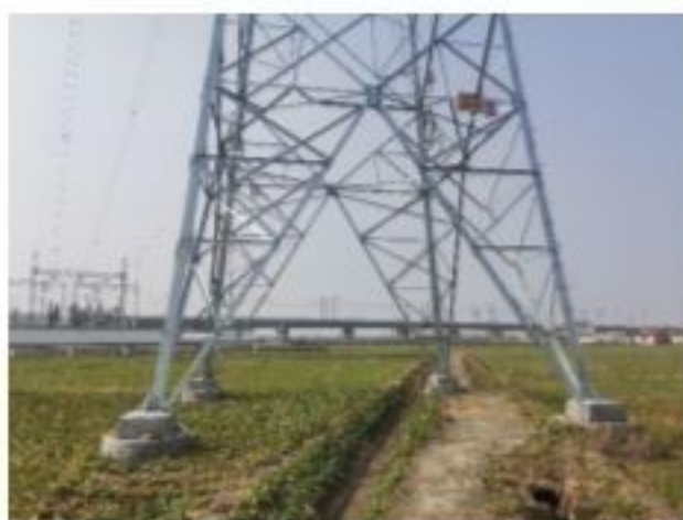
措施名称: 220kV 金牵 46X3 线 69#塔基复耕
