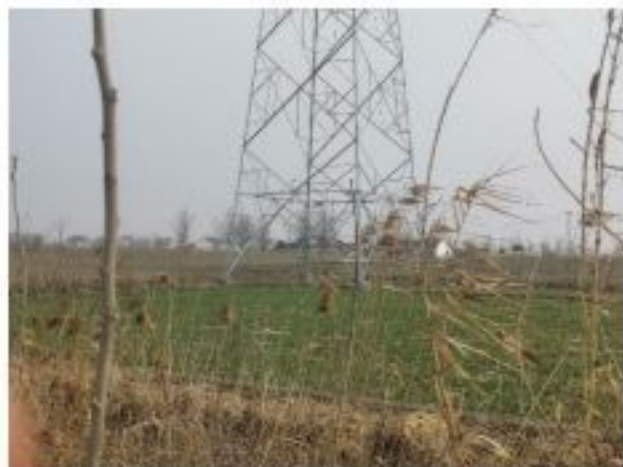
措施名称: 220kV 金牵 46X3/金衡 46X5 线 41#塔基复耕
