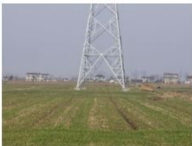
施名称: 220kV 金牵 46X3/金衡 46X5 线 50#塔基复耕
