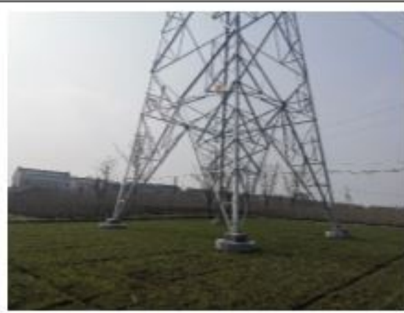
220kV 金牵 46X3/金衡 46X5 线 60#塔基复耕
