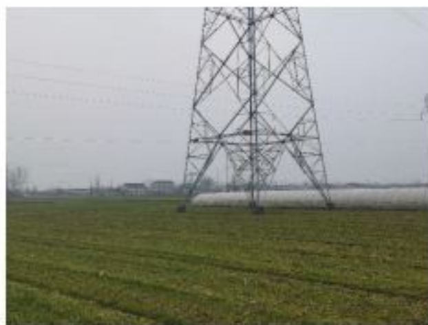
220kV 金牵 46X3/金衡 46X5 线 10#塔基复耕
