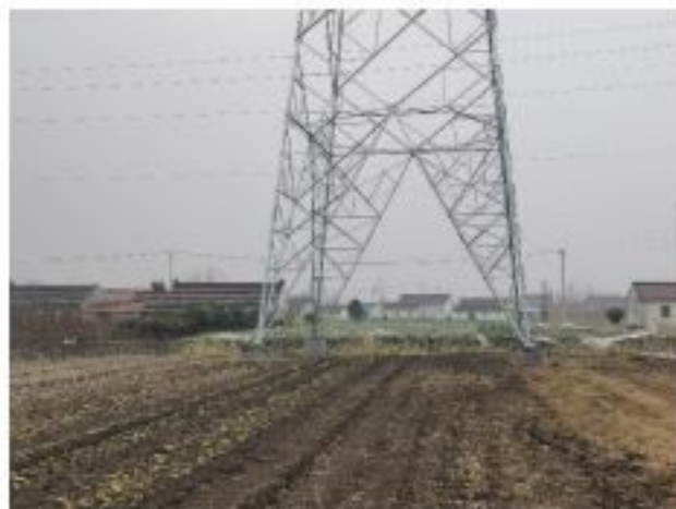
措施名称: 220kV 金牵 46X3/金衡 46X5 线 11#塔基复耕
