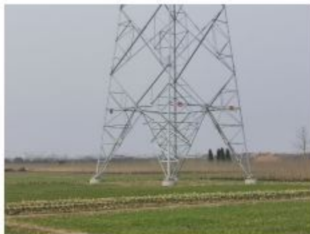
措施名称: 220kV 金牵 46X3/金衡 46X5 线 48#塔基复耕
