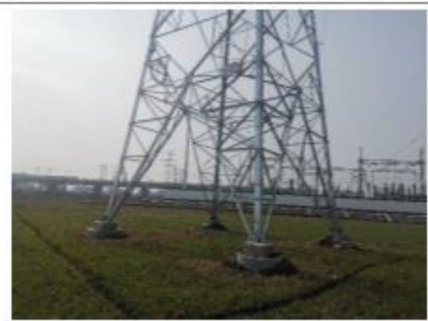
措施名称: 220kV 衡牵 46X4 线 92#塔基复耕
