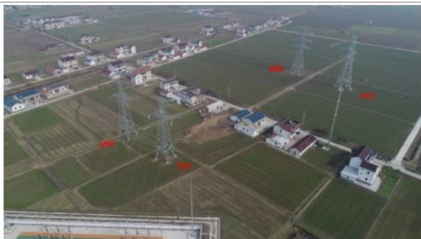
220kV 衡率 46X4 线 91#、92#塔基、220kV 金率 46X3 线 68#、69#塔基建设后航拍影像图
