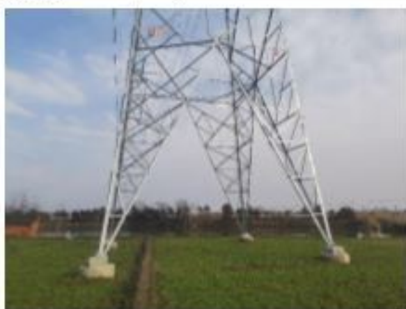
措施名称: 220kV 衡牵 46X4 线 35#塔基复耕
