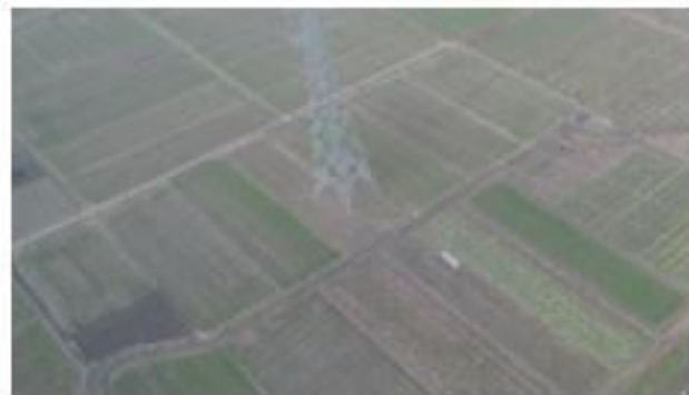
措施名称: 220kV 金牵 46X3/金衡 46X5 线 58#塔基复耕
