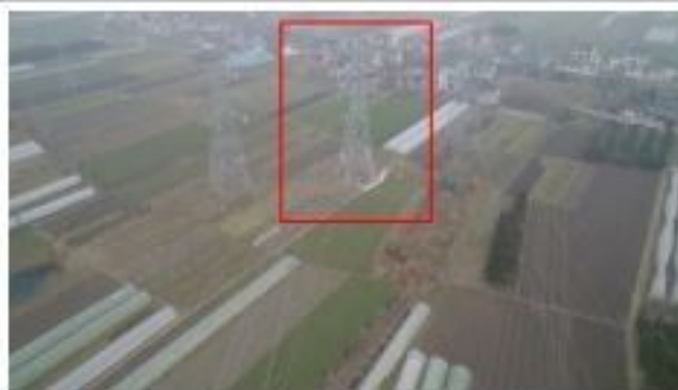
220kV 金牵 46X3/金衡 46X5 线 4#塔基复耕
