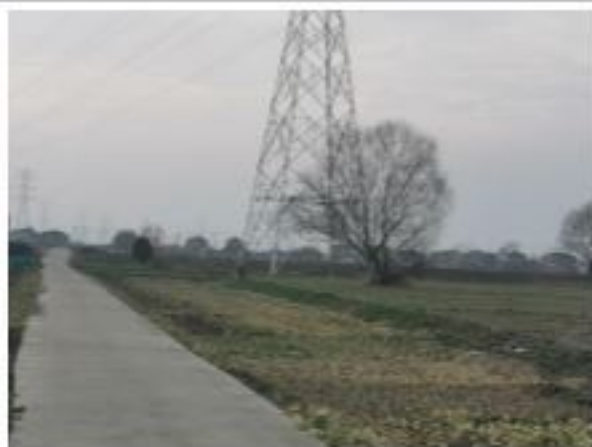
措施名称: 220kV 衡牵 46X4 线 48#塔基复耕
