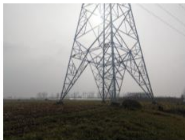
措施名称: 220kV 金牵 46X3/金衡 46X5 线 23#塔基复耕
