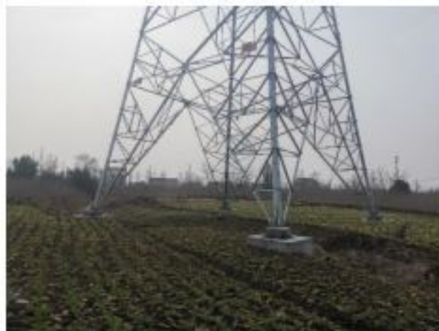
措施名称: 220kV 金牵 46X3/金衡 46X5 线 35#塔基复耕
