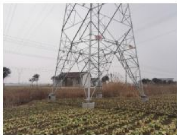
220kV 金牵 46X3/金衡 46X5 线 9#塔基复耕
