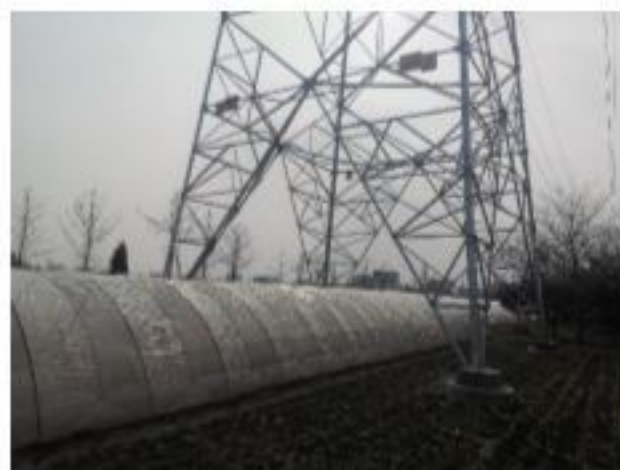
措施名称: 220kV 金牵 46X3/金衡 46X5 线 32#塔基复耕
