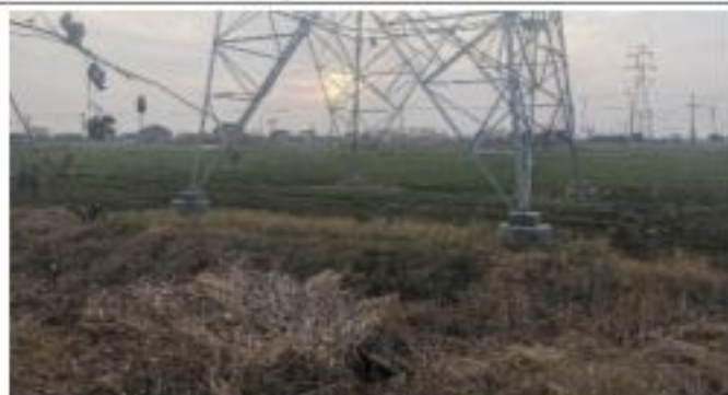
措施名称: 220kV 衡牵 46X4 线 64#塔基复耕
