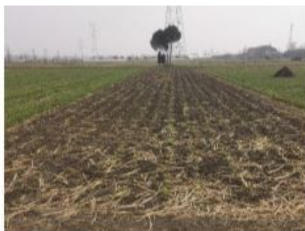
措施名称: 临时施工道路复耕
