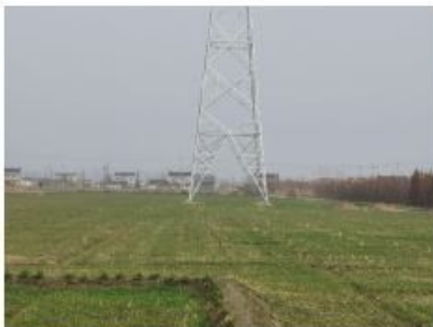
措施名称: 220kV 金牵 46X3/金衡 46X5 线 51#塔基复耕
