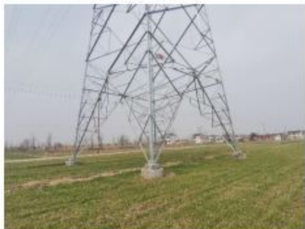
措施名称: 220kV 金牵 46X3/金衡 46X5 线 40#塔基复耕
