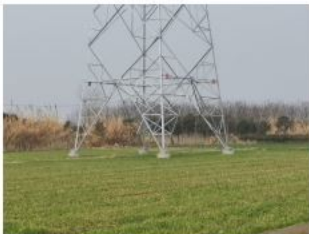
施名称: 220kV 金牵 46X3/金衡 46X5 线 47#塔基复耕
