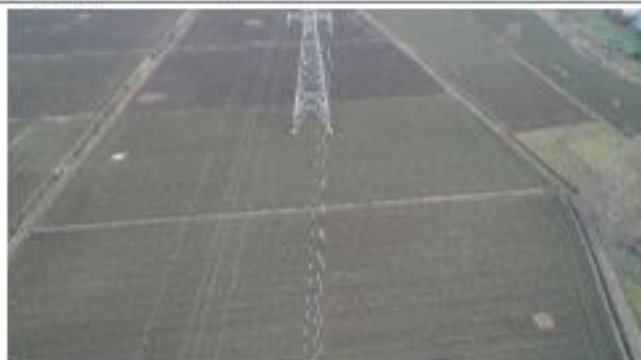
措施名称: 220kV 衡牵 46X4 线 61#塔基复耕
