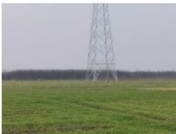
措施名称: 220kV 金牵 46X3/金衡 46X5 线 30#塔基复耕
