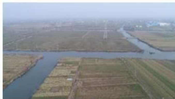
措施名称: 220kV 衡牵 46X4 线 15#塔基及跨越场区 (跨河流) 复耕
