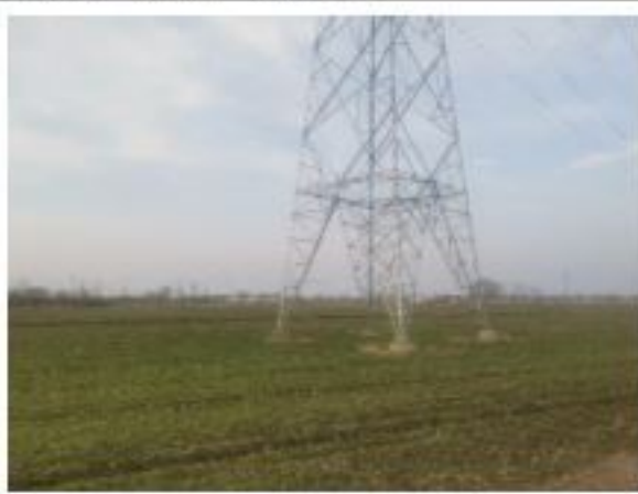
措施名称: 220kV 衡牵 46X4 线 54#塔基复耕
