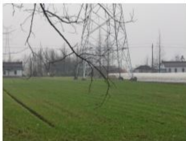
措施名称: 220kV 金牵 46X3/金衡 46X5 线 15#塔基及临时施工道路复耕
