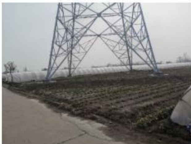
措施名称: 220kV 金牵 46X3/金衡 46X5 线 27#塔基复耕
