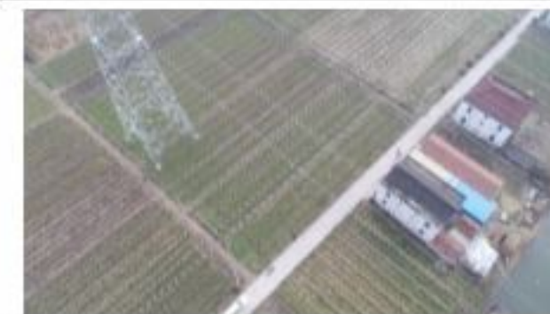
措施名称: 跨越区 (跨越 110kV 线路) 复耕
