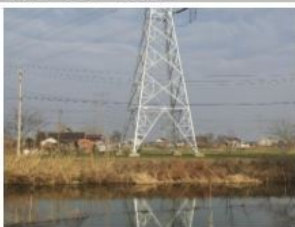
措施名称: 220kV 衡牵 46X4 线 42#塔基复耕
