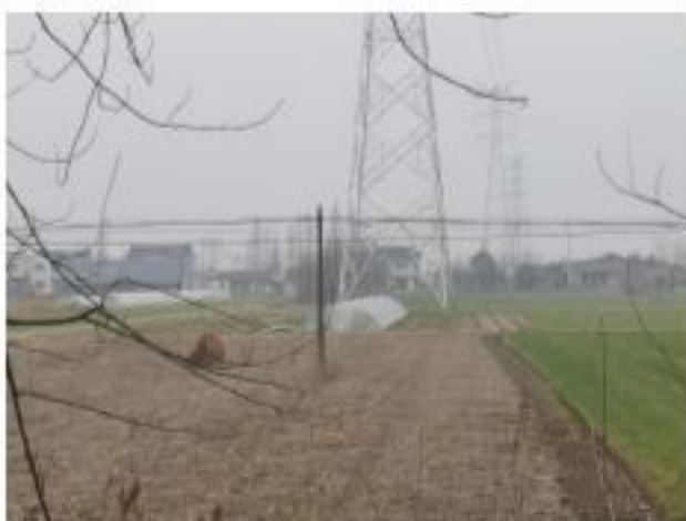
措施名称: 220kV 金牵 46X3/金衡 46X5 线 14#塔基复耕
