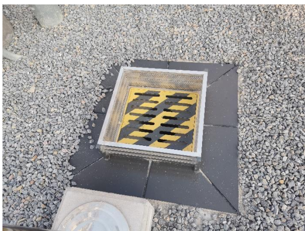
变电站区雨水井 (2020.12.23)
