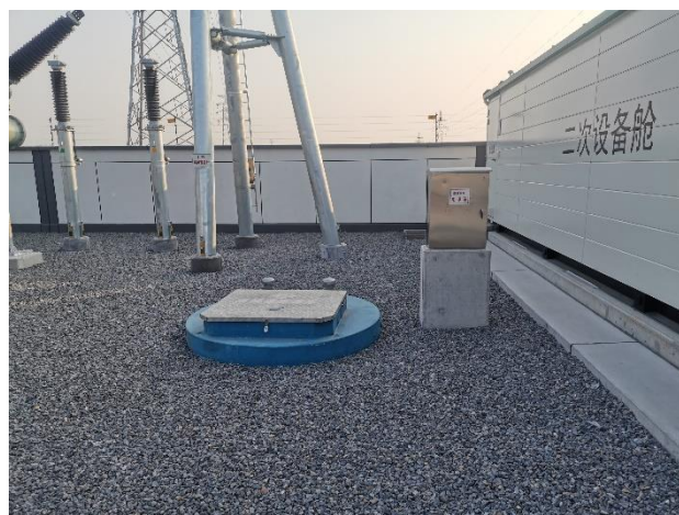
变电站区碎石压盖 (2020.12.23)
