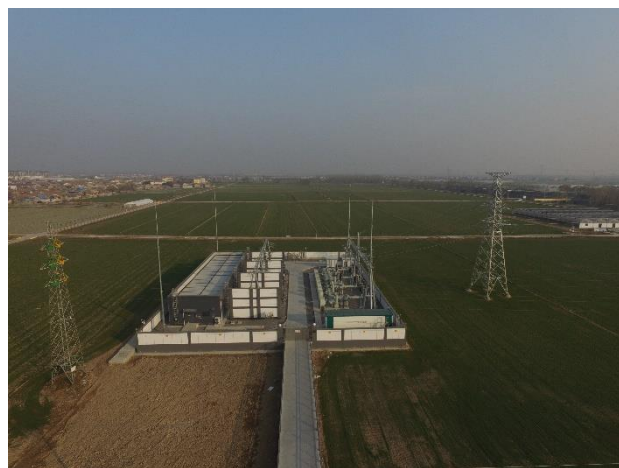
变电站区整治土地后撒播草籽 (2020.12.23)
