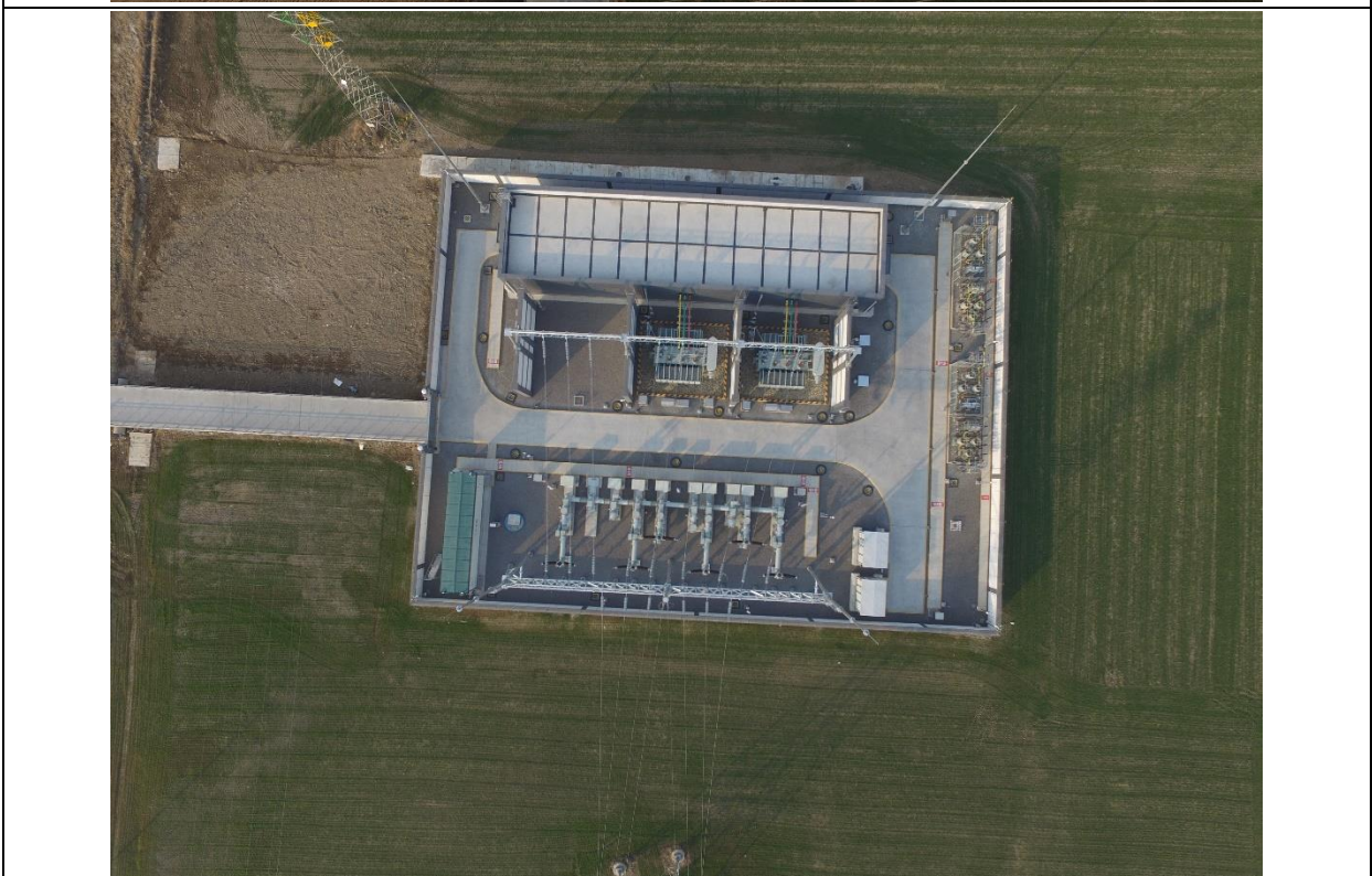
110kV 仙桃变、#1 塔基建设后航拍影像图
