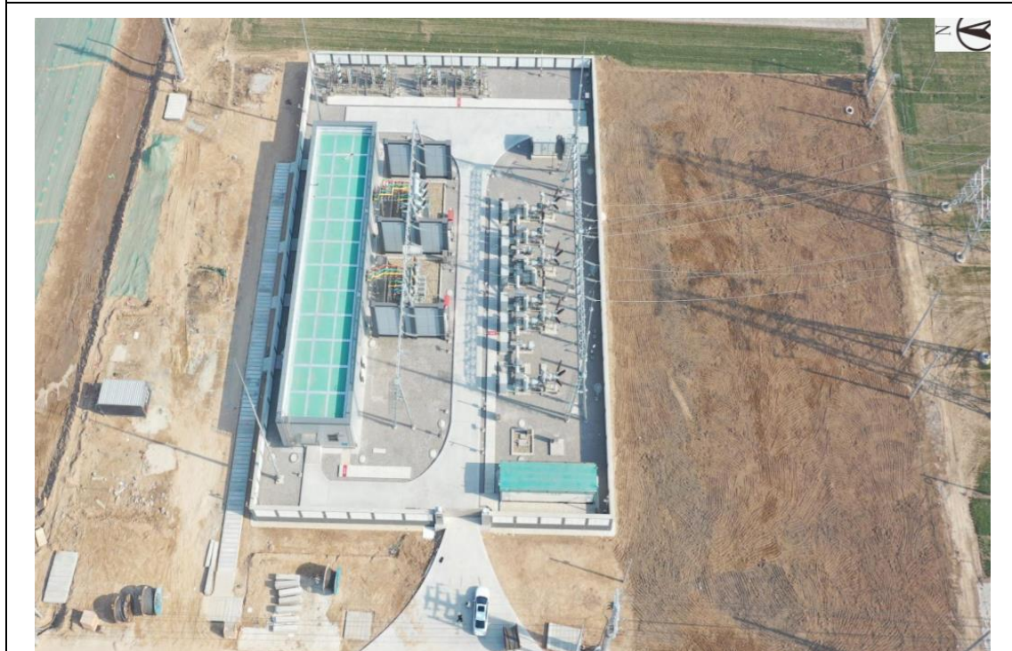
变电站及施工生产生活区恢复情况航拍（摄于 2021 年 1 月）
