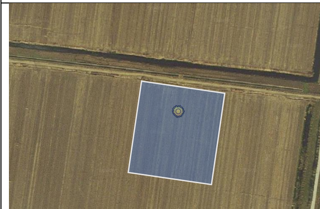
220kV 御密变 (2018 年 6 月)
