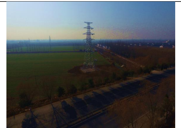
电缆终端塔 (2021 年 1 月)
