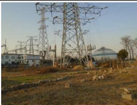
110kV 蔷薇 744 线#39 杆塔穿越通榆河（连云港市区）清水通道维护区照片
