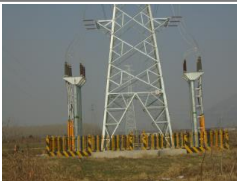
110kV 蔷邓 741 线#51 杆塔穿越通榆河（连云港市区）清水通道维护区照片
