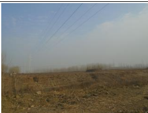
110kV 房汤 8N1 线自 110kV 汤庄变出线第 4~第 5 基杆塔一档跨越石安河照片
