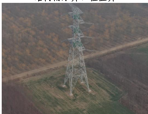
塔基耕地恢复
