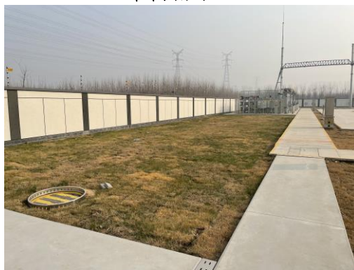
站内铺设草皮
