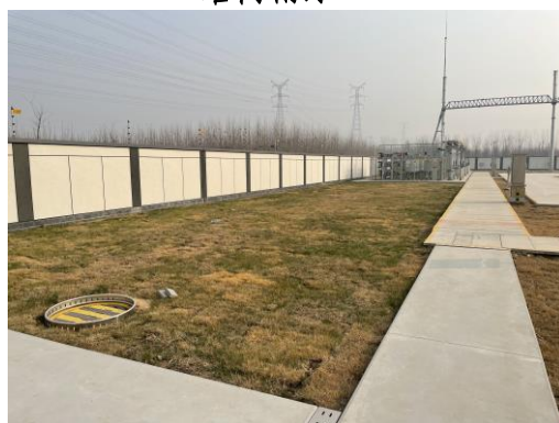
站内铺设草皮
