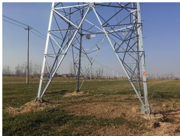
110kV 子安 891/子鲁 998 线 11#塔基复耕 (2020.12)
