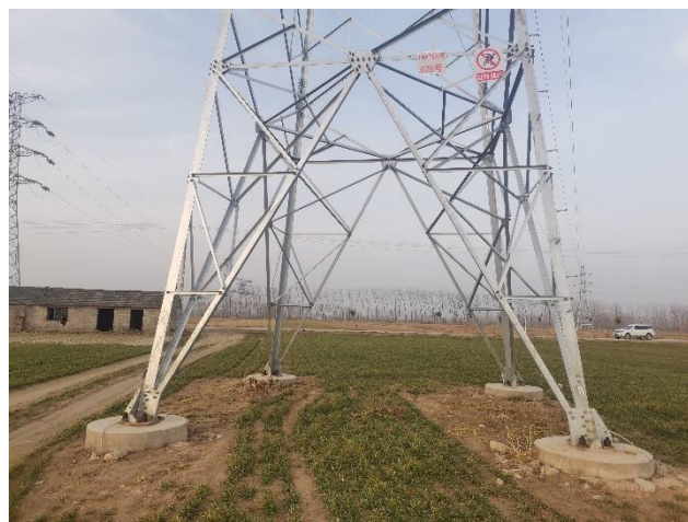
110kV 子鲁 998 线 76#塔基复耕 (2020.12)
