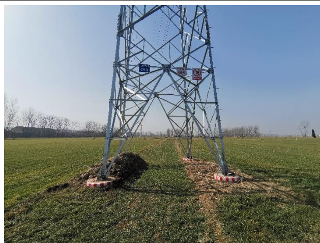
110kV 子安 891/子鲁 998 线 26#塔基复耕(2020.12)
