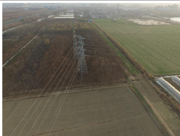
110kV 庆画 8M0 线安宁 T 接线 4#塔基植被恢复 (2020.12)
