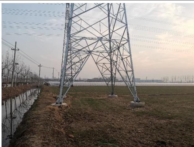
110kV 庆画 8M0 线安宁 T 接线 5#塔基复耕 (2020.12)
