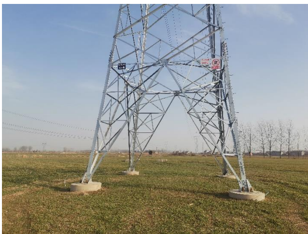
110kV 子鲁 998 线 40#塔基复耕 (2020.12)
