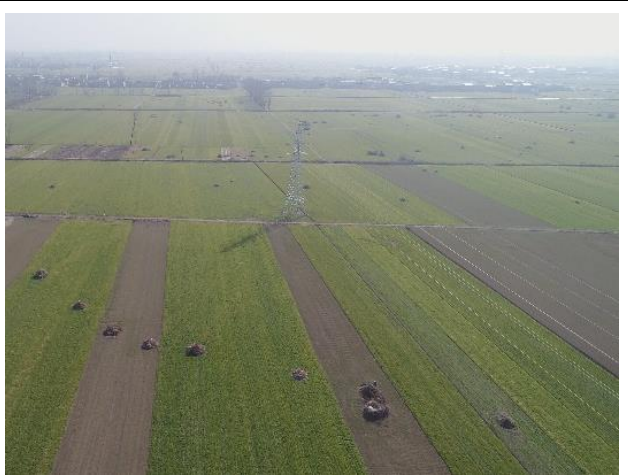
110kV 子安 891/子鲁 998 线 17#塔基及牵张场复耕 (2020.12)
