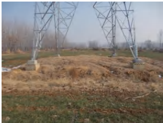
塔基区 T14 复耕、撒播草籽 (2021.1.21)
