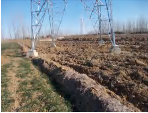
塔基区 T42 复耕 (2021.1.21)
