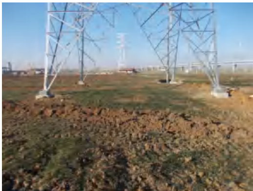
塔基区 T37 复耕 (2021.1.21)
