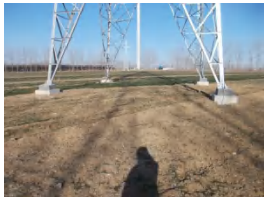
塔基区 T39 复耕 (2021.1.21)
