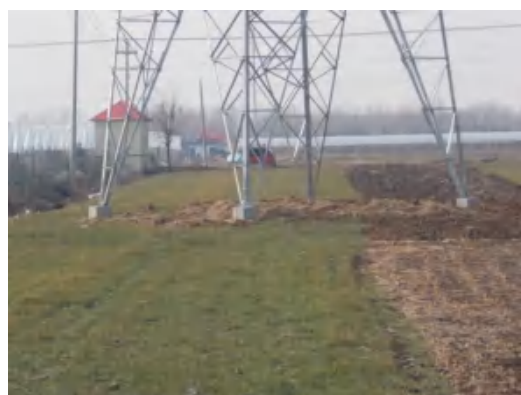
塔基区 T5 复耕 (2021.1.21)
