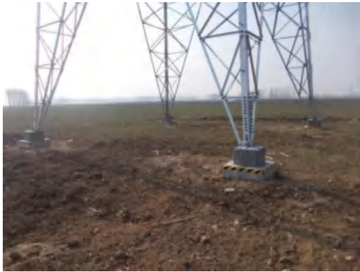
塔基区 T20 复耕 (2021.1.21)
