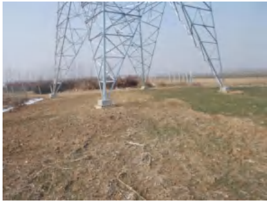
塔基区 T12 复耕 (2021.1.21)
