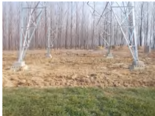
塔基区 T15 复耕 (2021.1.21)
