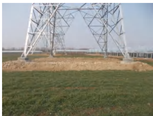
塔基区 T4 复耕 (2021.1.21)
