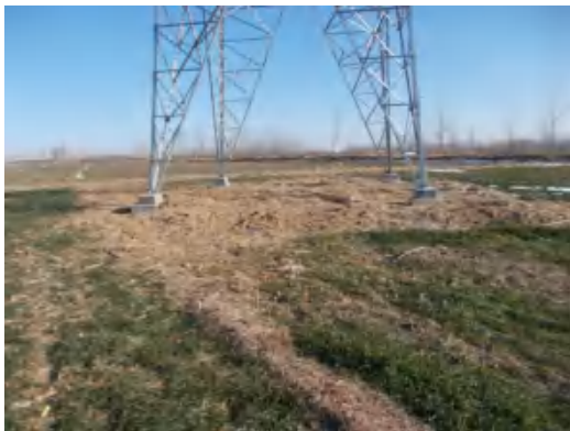
塔基区 T40 复耕 (2021.1.21)
