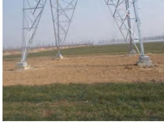
塔基区 T18 复耕 (2021.1.21)
