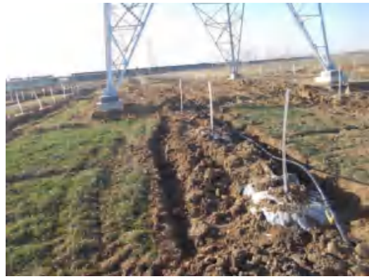
塔基区 T36 复耕 (2021.1.21)
