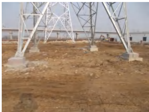
塔基区 T1 复耕 (2021.1.21)
