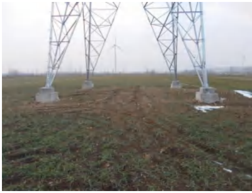
塔基区 T23 复耕 (2021.1.21)
