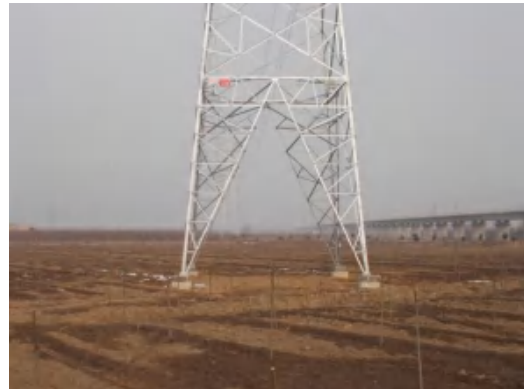
塔基区 T14 复耕 (2021.1.21)
