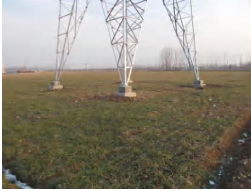
塔基区 T29 复耕 (2021.1.21)
