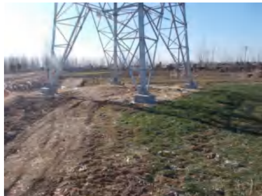
塔基区 T45 复耕 (2021.1.21)
