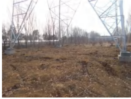
塔基区 T5 复耕 (2021.1.21)
