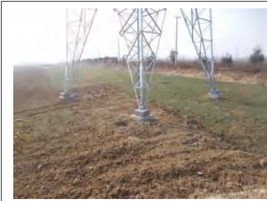
塔基区 T10 复耕 (2021.1.21)
