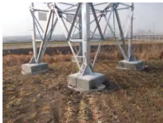
塔基区 T8 复耕 (2021.1.21)
