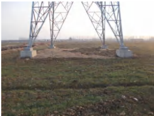
塔基区 T31 复耕 (2021.1.21)
