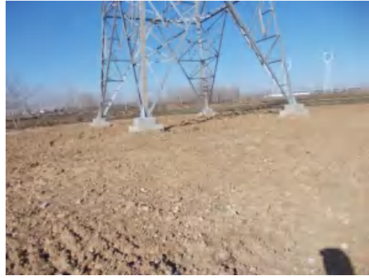
塔基区 T43 复耕 (2021.1.21)
