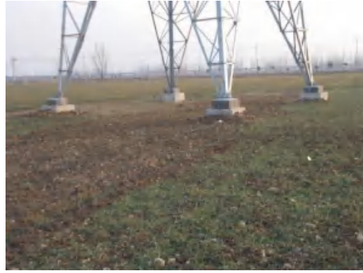
塔基区 T30 复耕 (2021.1.21)
