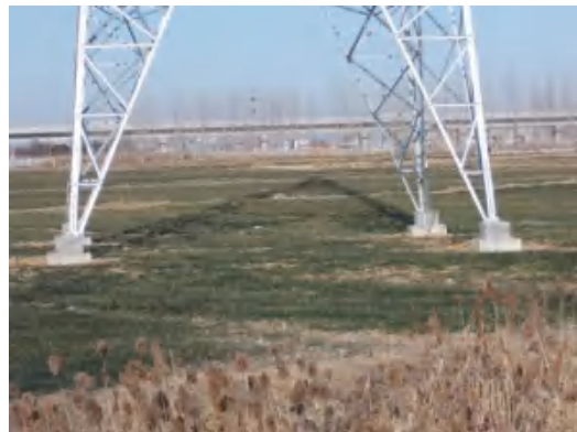
塔基区 T41 复耕、撒播草籽 (2021.1.21)
