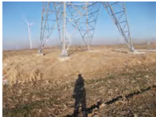
塔基区 T34 复耕、撒播草籽 (2021.1.21)
