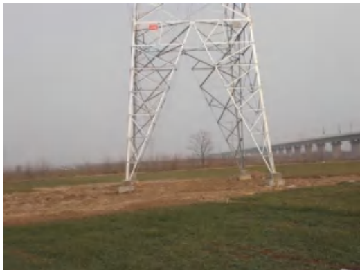
塔基区 T15 复耕 (2021.1.21)
