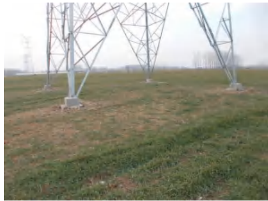
塔基区 T26 复耕 (2021.1.21)
