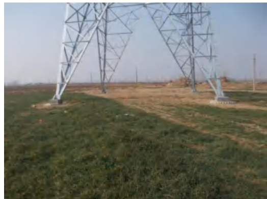
塔基区 T24 复耕、撒播草籽 (2021.1.21)
