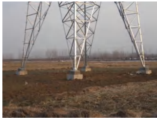
塔基区 T28 复耕 (2021.1.21)
