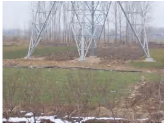
塔基区 T24 复耕 (2021.1.21)
