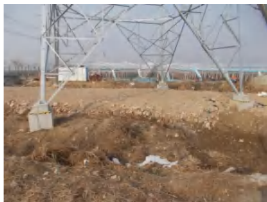
塔基区 T7 复耕 (2021.1.21)
