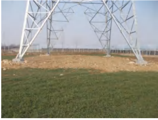
塔基区 T4 复耕、撒播草籽 (2021.1.21)
