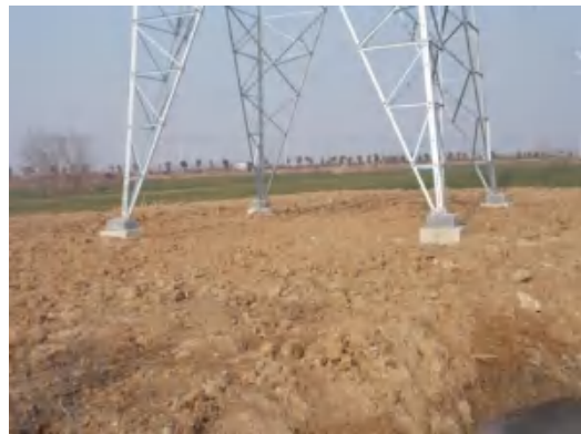
塔基区 T9 复耕 (2021.1.21)
