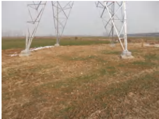
塔基区 T12 复耕 (2021.1.21)
