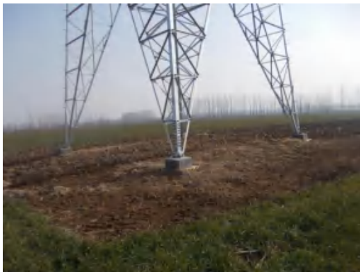
塔基区 T23 复耕 (2021.1.21)
