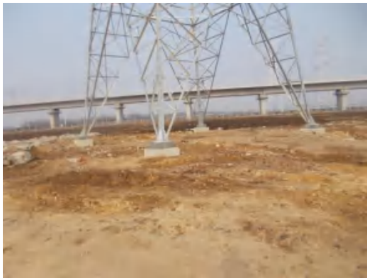
塔基区 T2 复耕 (2021.1.21)
