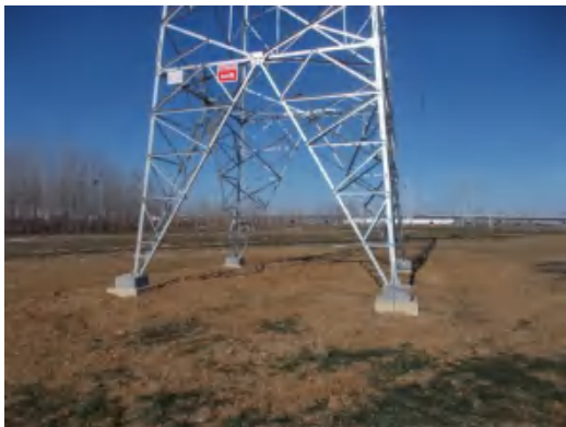
塔基区 T44 复耕 (2021.1.21)
