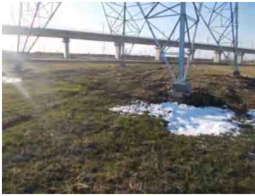
塔基区 T35 复耕 (2021.1.21)
