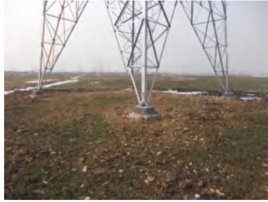
塔基区 T11 复耕 (2021.1.21)
