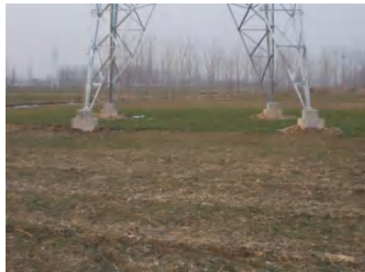
塔基区 T32 复耕 (2021.1.21)
