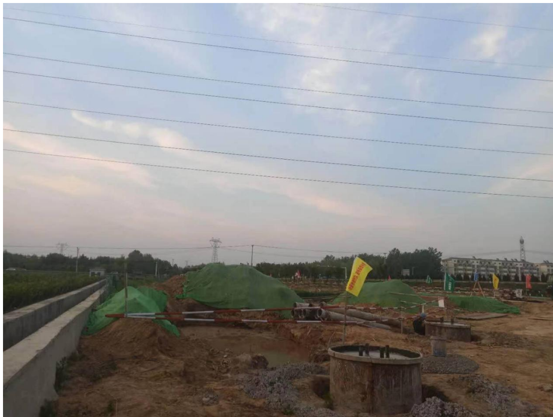
塔基区泥浆沉淀池（2020 年 6 月）
