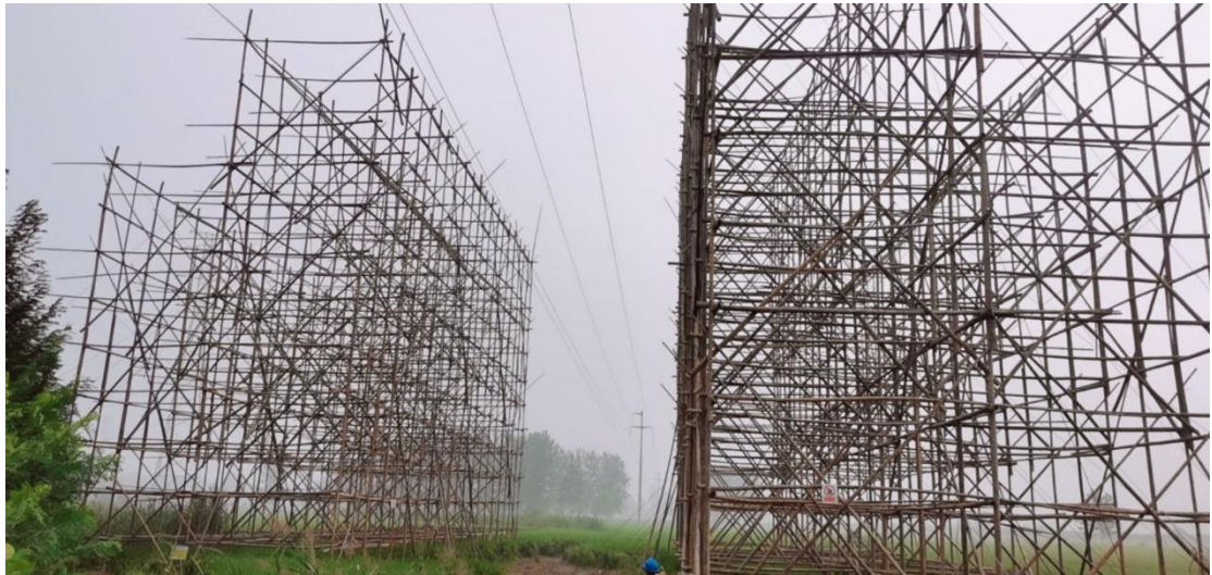
T6-T7 跨越 35kv 线路
