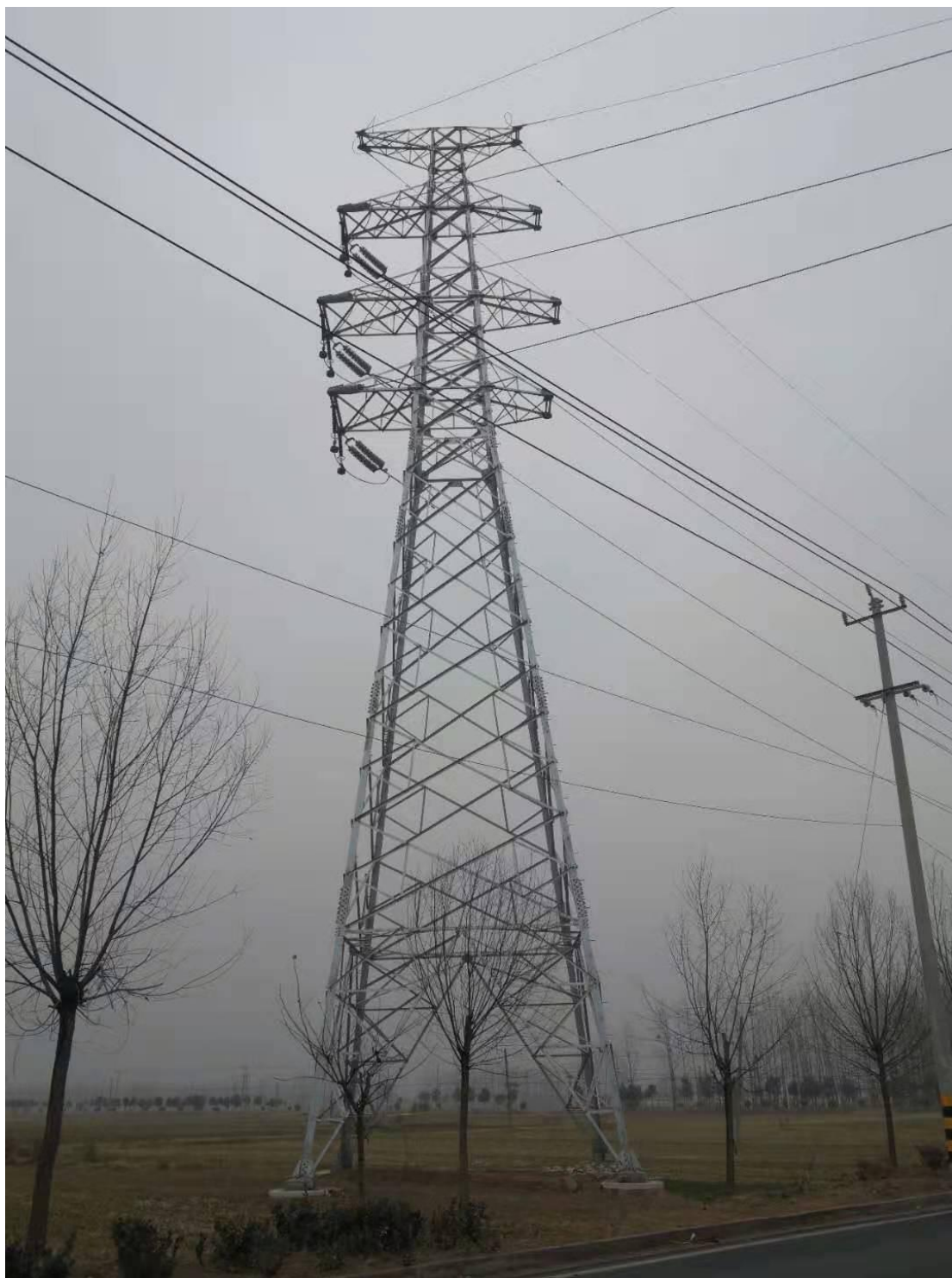
塔基区 (T1) 土地整治 (2021 年 1 月)
