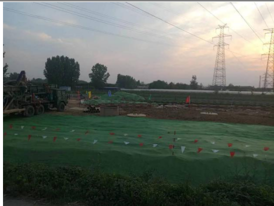
塔基区防尘网苫盖 (2020 年 6 月)
