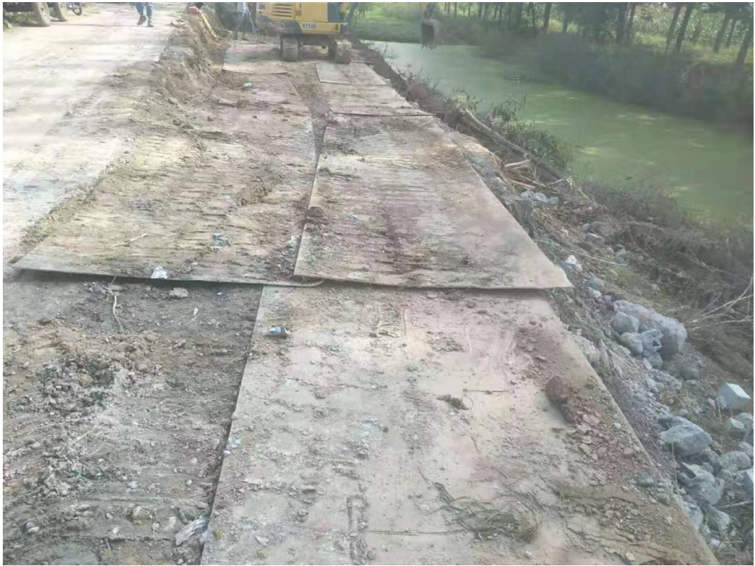
施工临时道路区铺设钢板（2020 年 6 月）
