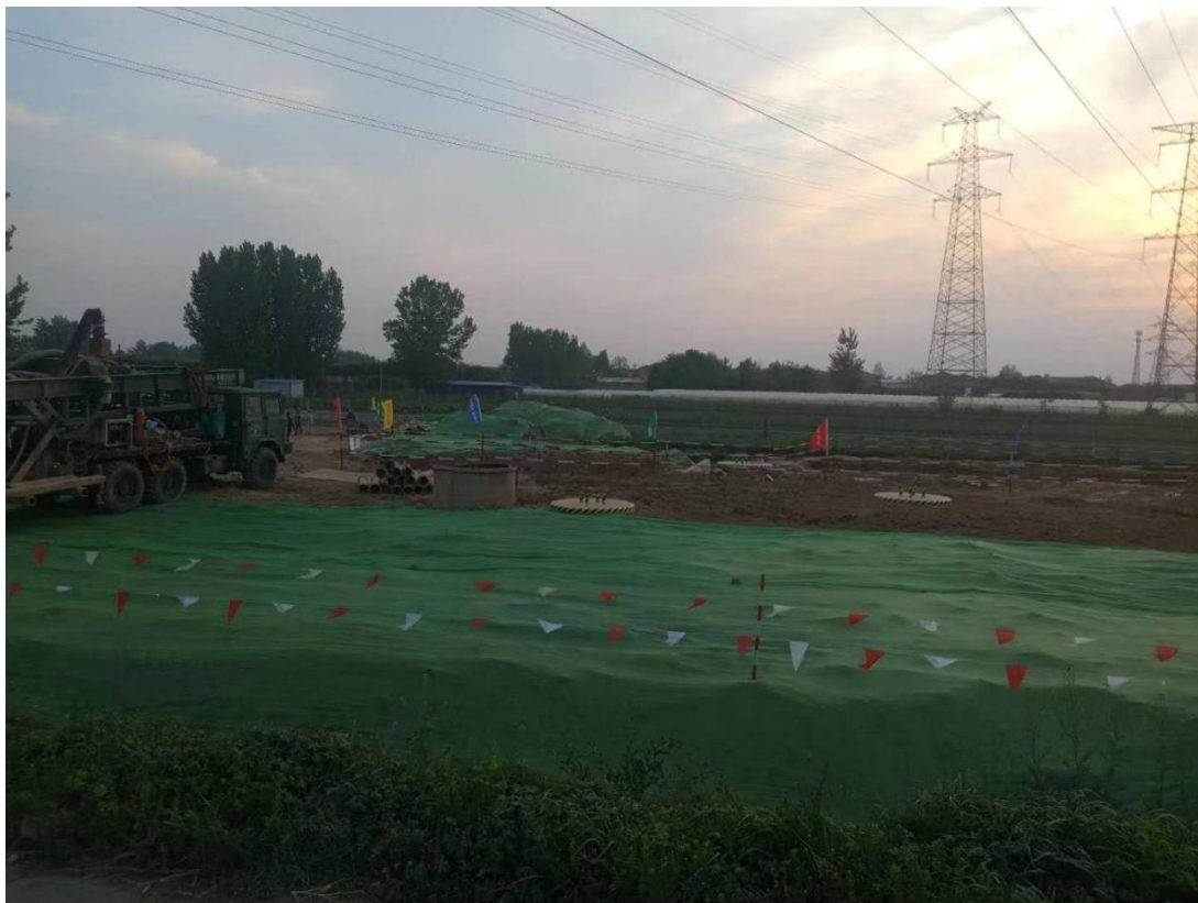
塔基区防尘网苫盖（2020 年 6 月）
