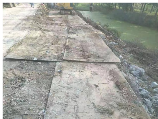
塔基区铺设钢板（2020 年 6 月）
