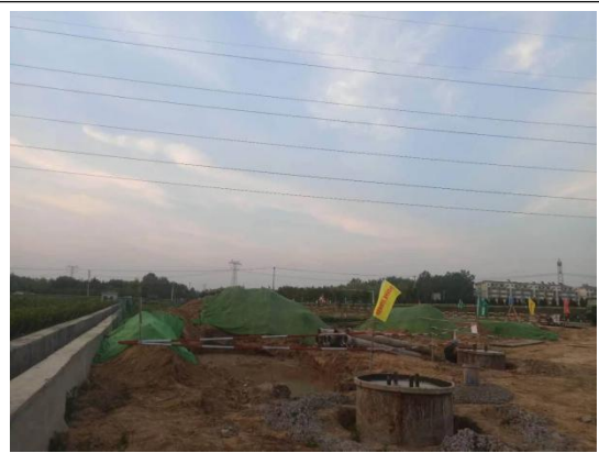
塔基区泥浆沉淀池 (2020 年 6 月)
