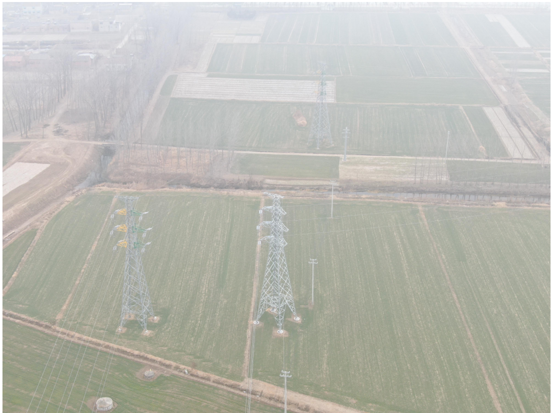
塔基区复耕（2021 年 1 月）
