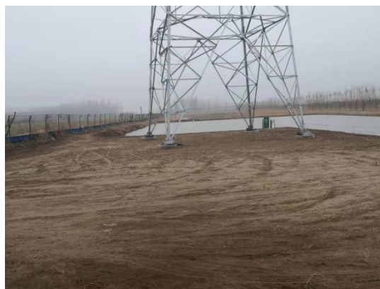
塔基区土地整治（2020 年 12 月）
