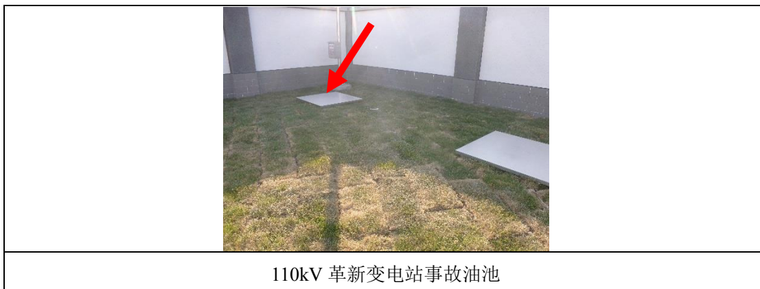
图 8-2 本次验收的变电站事故油池示例
