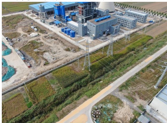
汤沐变电站出线塔基恢复
