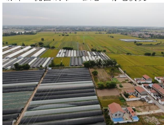
汤沐 ~ 桃园线路工程施工场地恢复-3
