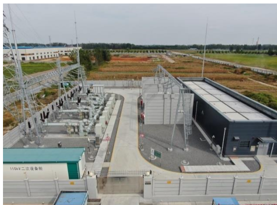
汤沐变电站场地（铺设碎石、排水设施）
