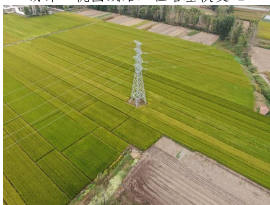
汤沐 ~ 桃园线路工程塔基恢复-4
