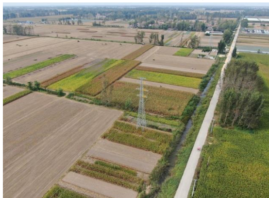
汤沐～位庄线路工程施工场地恢复-2
