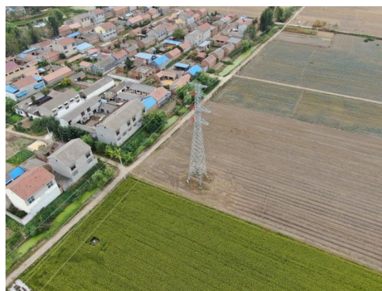
汤沐 ~ 桃园线路工程塔基恢复-1
