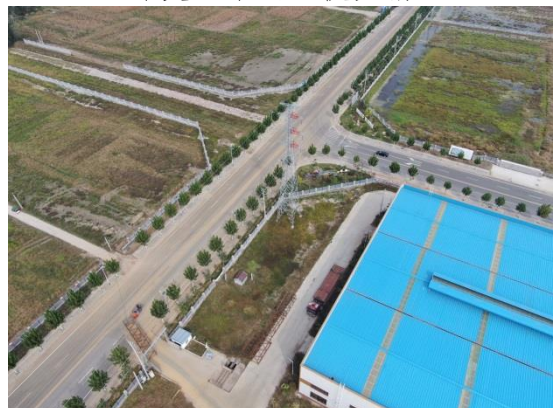
汤沐～位庄线路工程塔基恢复-1
