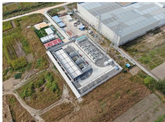
汤沐变电站周边恢复情况
