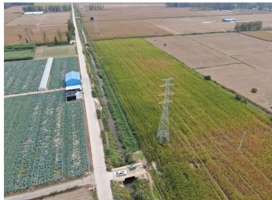
汤沐～位庄线路工程施工场地恢复-3
