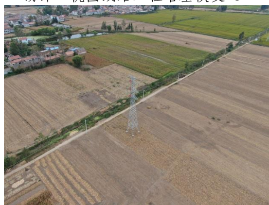
汤沐 ~ 桃园线路工程施工场地恢复-1
