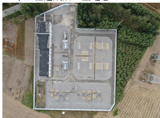
本工程建成后 110kV 任庄变电站低空照片 (2020.9)
