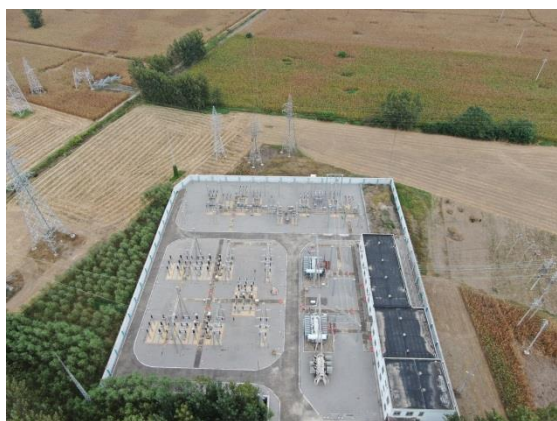
位庄 220kV 变电站
