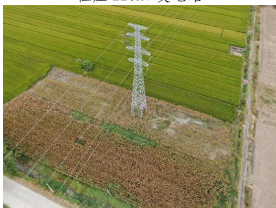
汤沐 ~ 桃园线路工程塔基恢复-2
