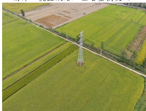
汤沐 ~ 桃园线路工程塔基恢复-3
