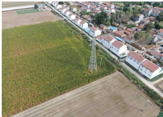
汤沐～位庄线路工程塔基恢复-2
