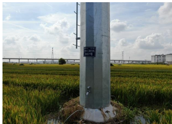
线路塔基恢复-1 (复耕)
