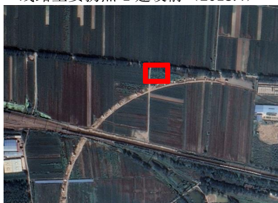
线路主要拐点-2 建设前 (2018.4)
