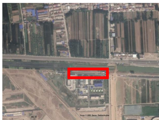
垃圾燃烧电厂线路进线区域建设后 (2020.5)
