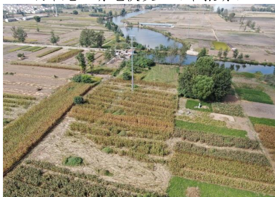
线路施工场地恢复-1 (牵张场、施工道路)
