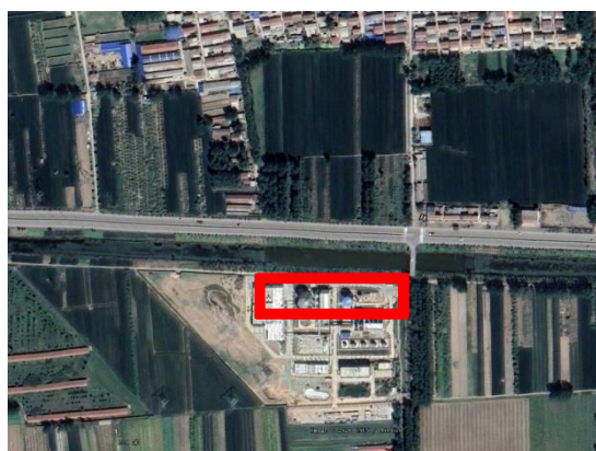
垃圾燃烧电厂线路进线区域建设前 (2018.4)
