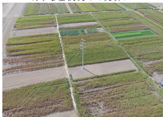
线路施工场地恢复-2 (牵张场)
