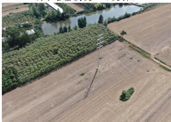
线路施工场地恢复-1 (牵张场)
