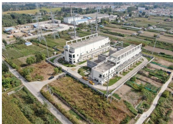
220kV 丁楼站出线间隔区域
