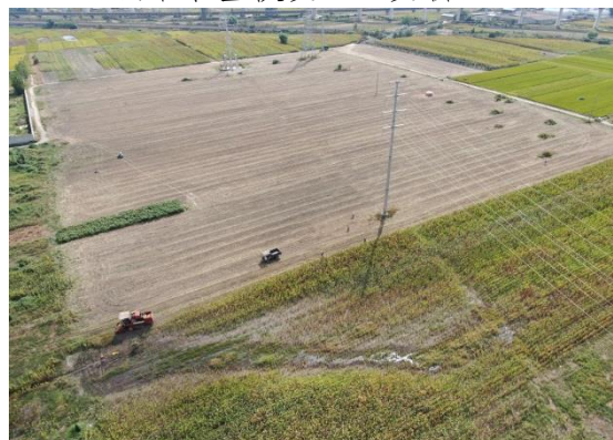
线路塔基恢复-3 (复耕)
