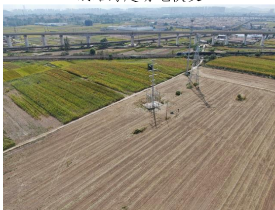
电缆施工场地恢复-2
