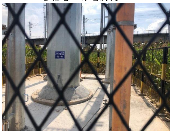
电缆登杆塔塔基恢复-1
