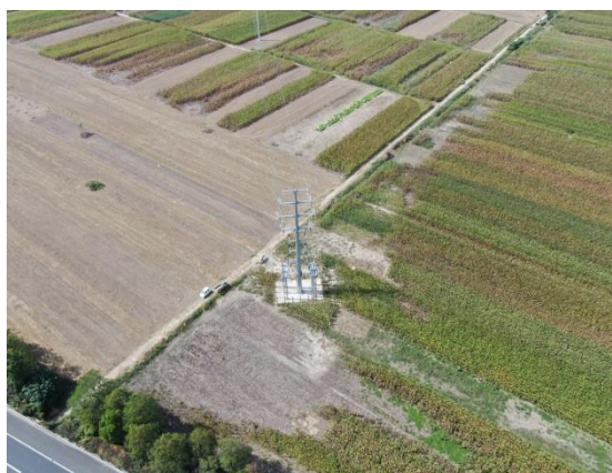
电缆施工场地恢复-1
