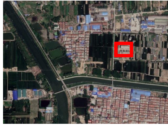
220kV 丁楼变电站建设后 (2020.5)
