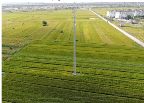
线路塔基恢复-2 (复耕)
