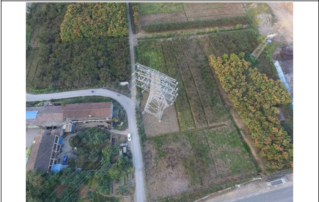
#4 塔基建设后航拍影像图
