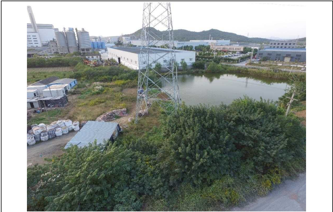
#3 塔基建设后航拍影像图
