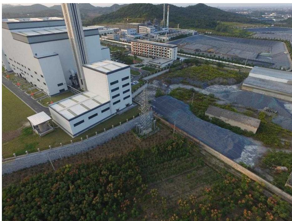
#1 塔基地建设后航拍影像图
