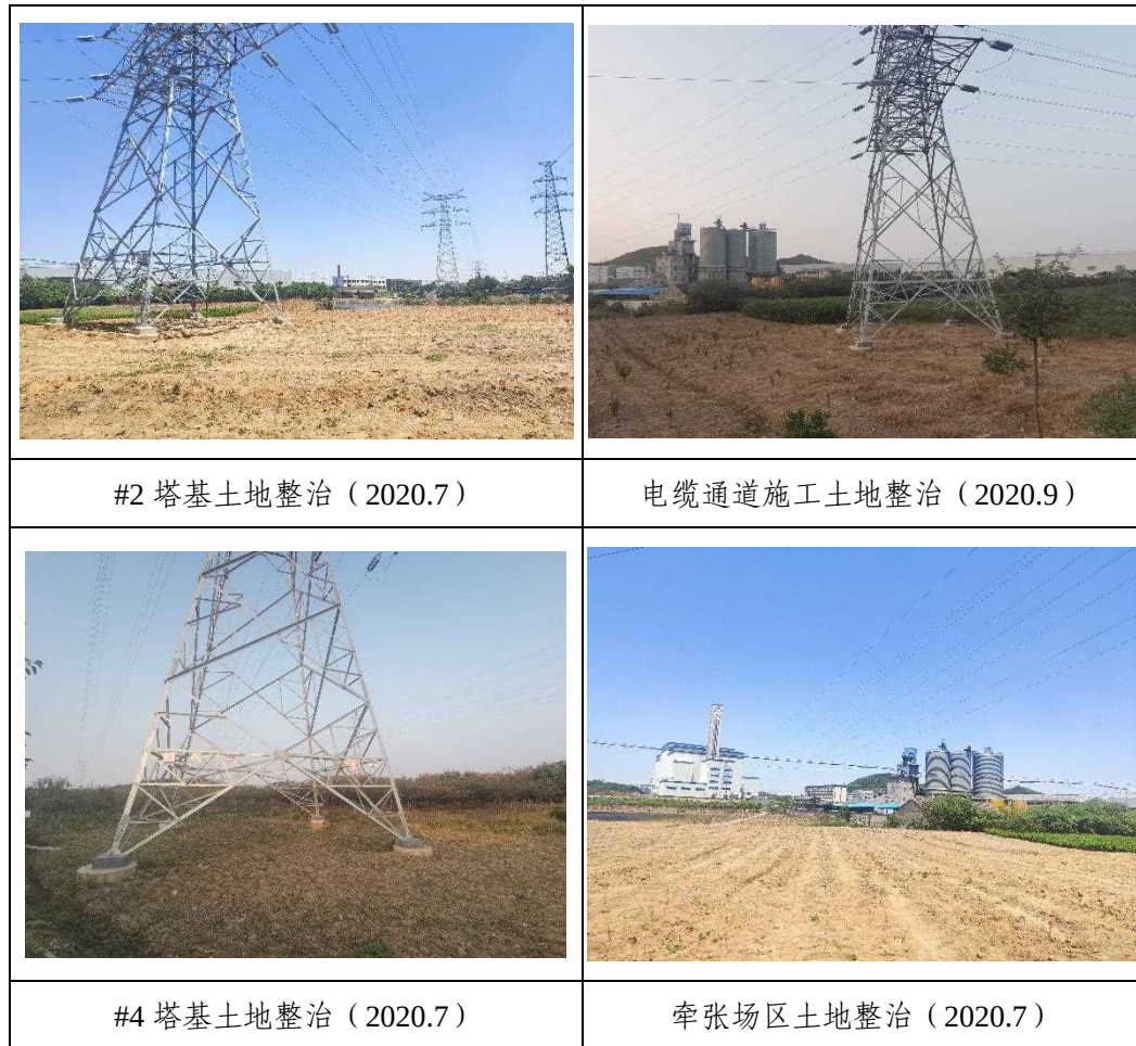
图 4-1 工程措施实施情况
