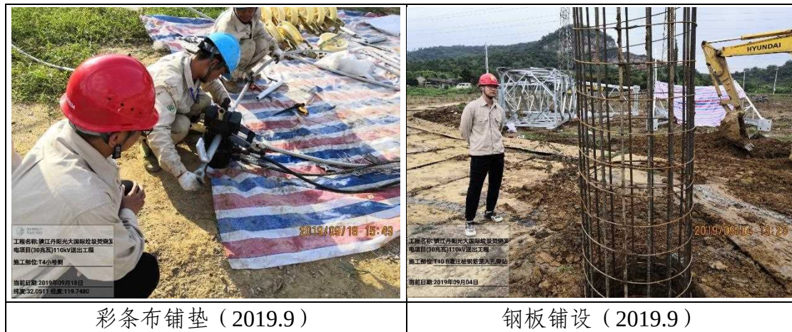
图 4-3 临时措施实施情况
