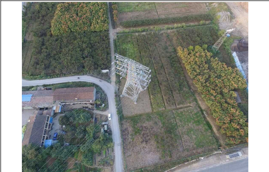
#4 塔基建设后航拍影像图
