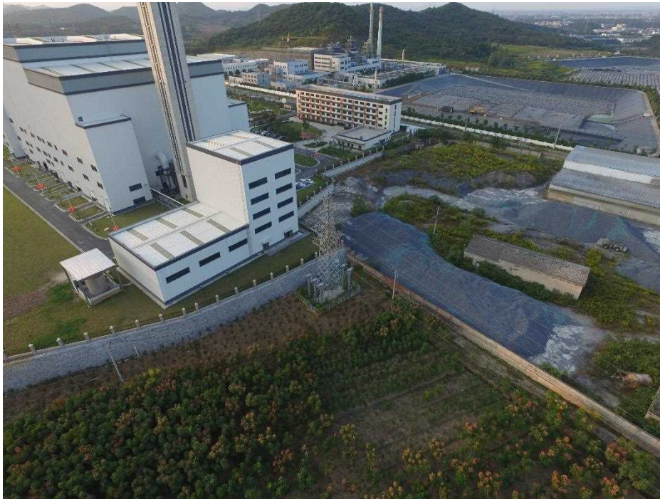
#1 塔基建设后航拍影像图
