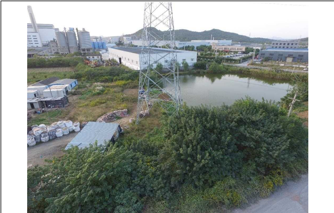
#3 塔基建设后航拍影像图
