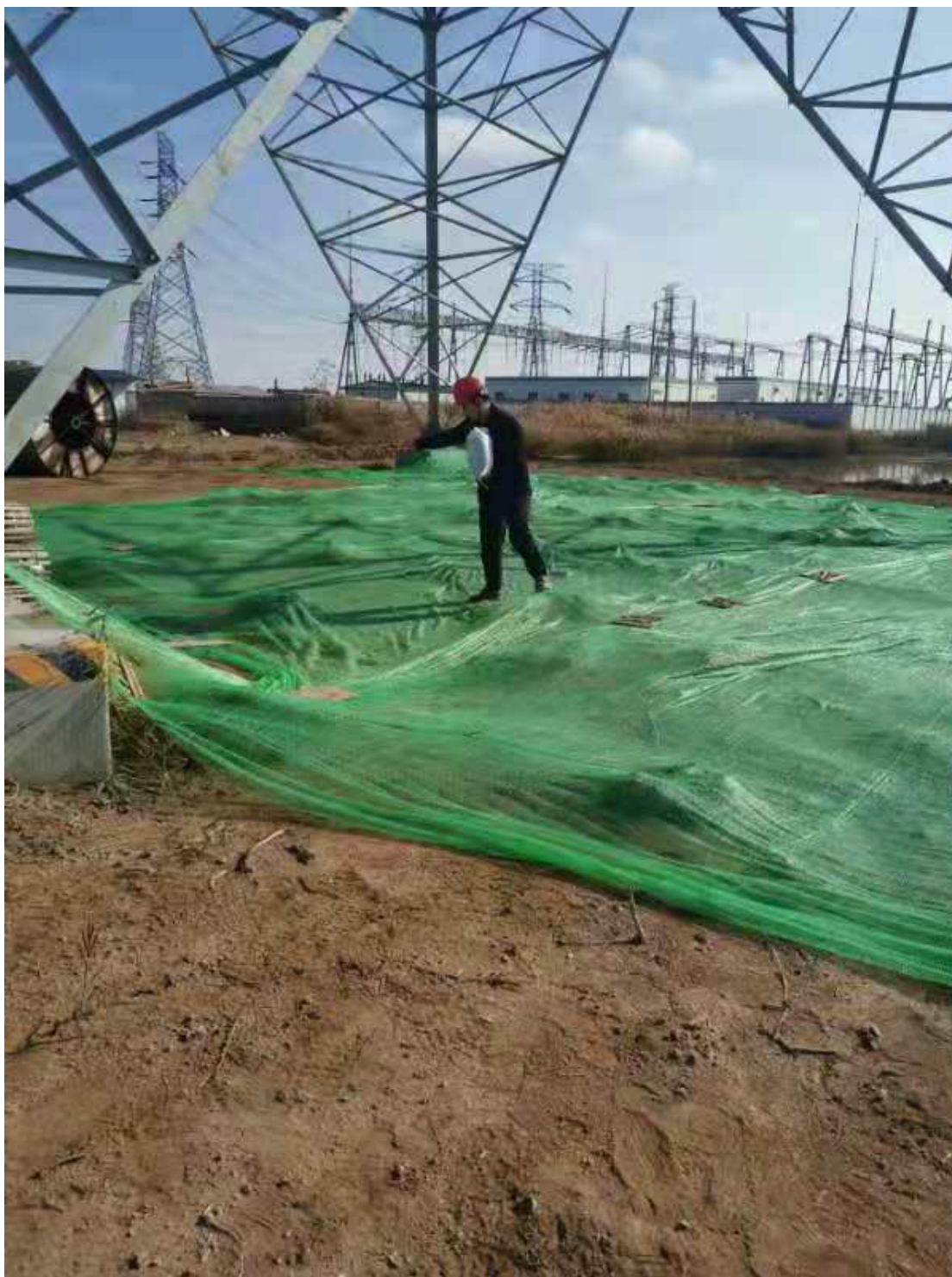
附图 5 施工现场撒播草籽图
