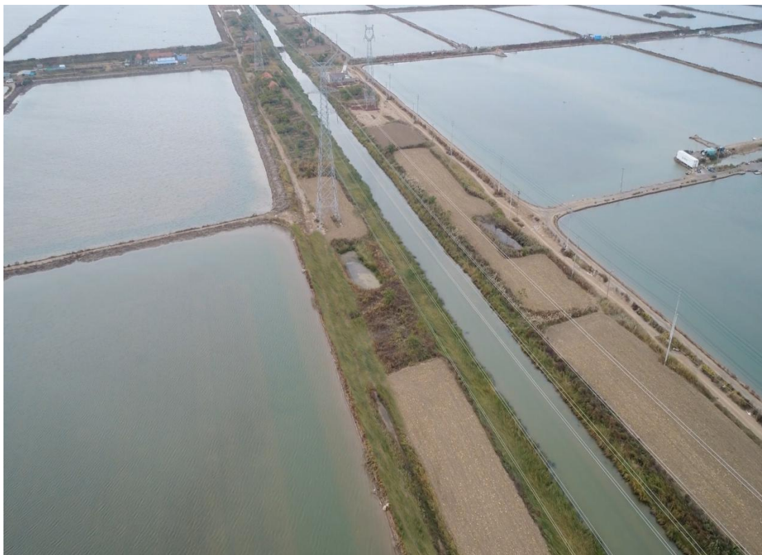
附图 4 施工临时道路航拍图
