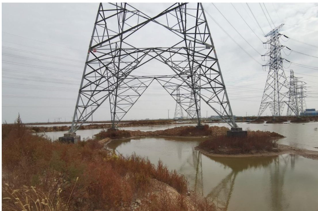
附图 3 塔基区植被措施
