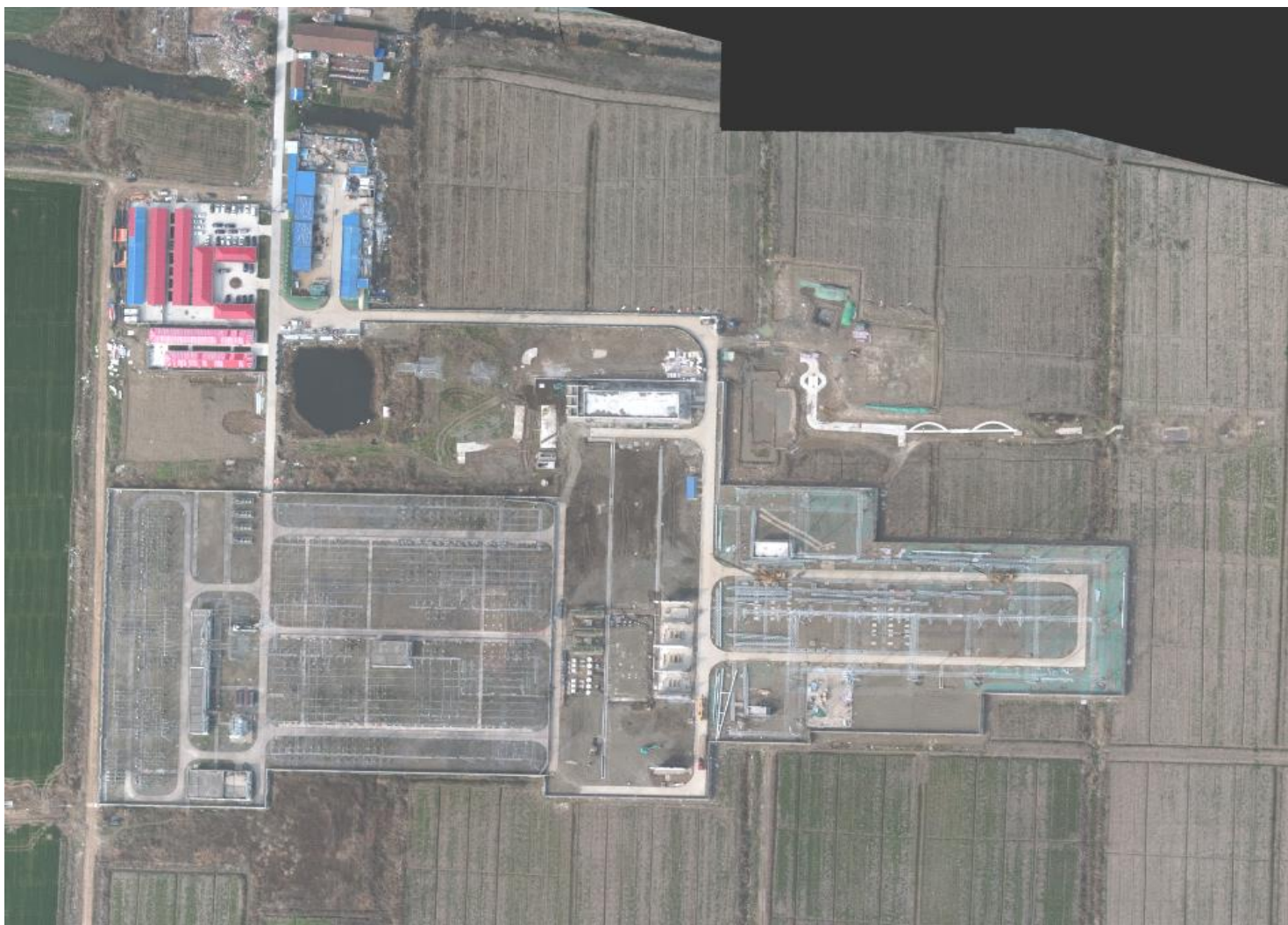
2019年3月（无人机高清航片，主体安装阶段）
