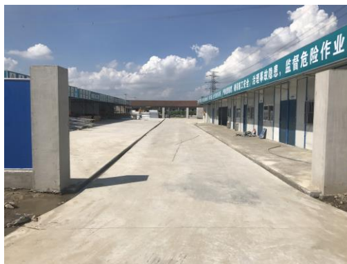
施工生产区临时排水沟
