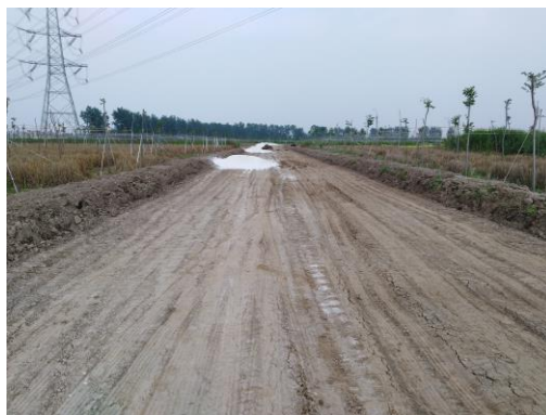
施工道路表土剥离 (2018.7)
