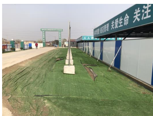
进站道路密目网苫盖
