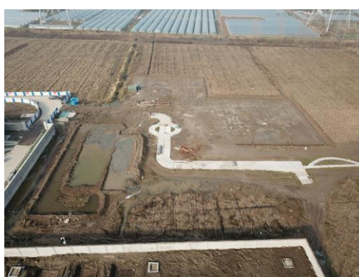
塔基区泥浆沉淀池
