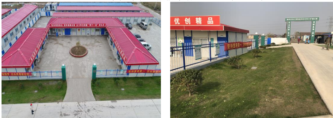
施工生产生活区铺设草皮、栽植灌木（2018年7~8月）
