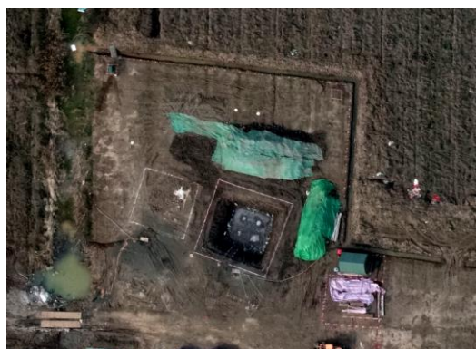
塔基堆土临时苫盖
