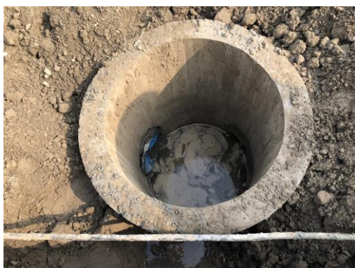
站区雨水排水管 (2018.12)
