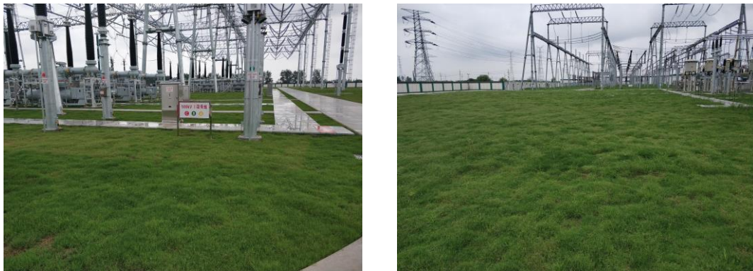
新丰变电站区铺设草皮（2019年6-7月）
