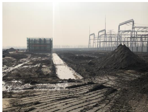
站区临时土质排水沟
