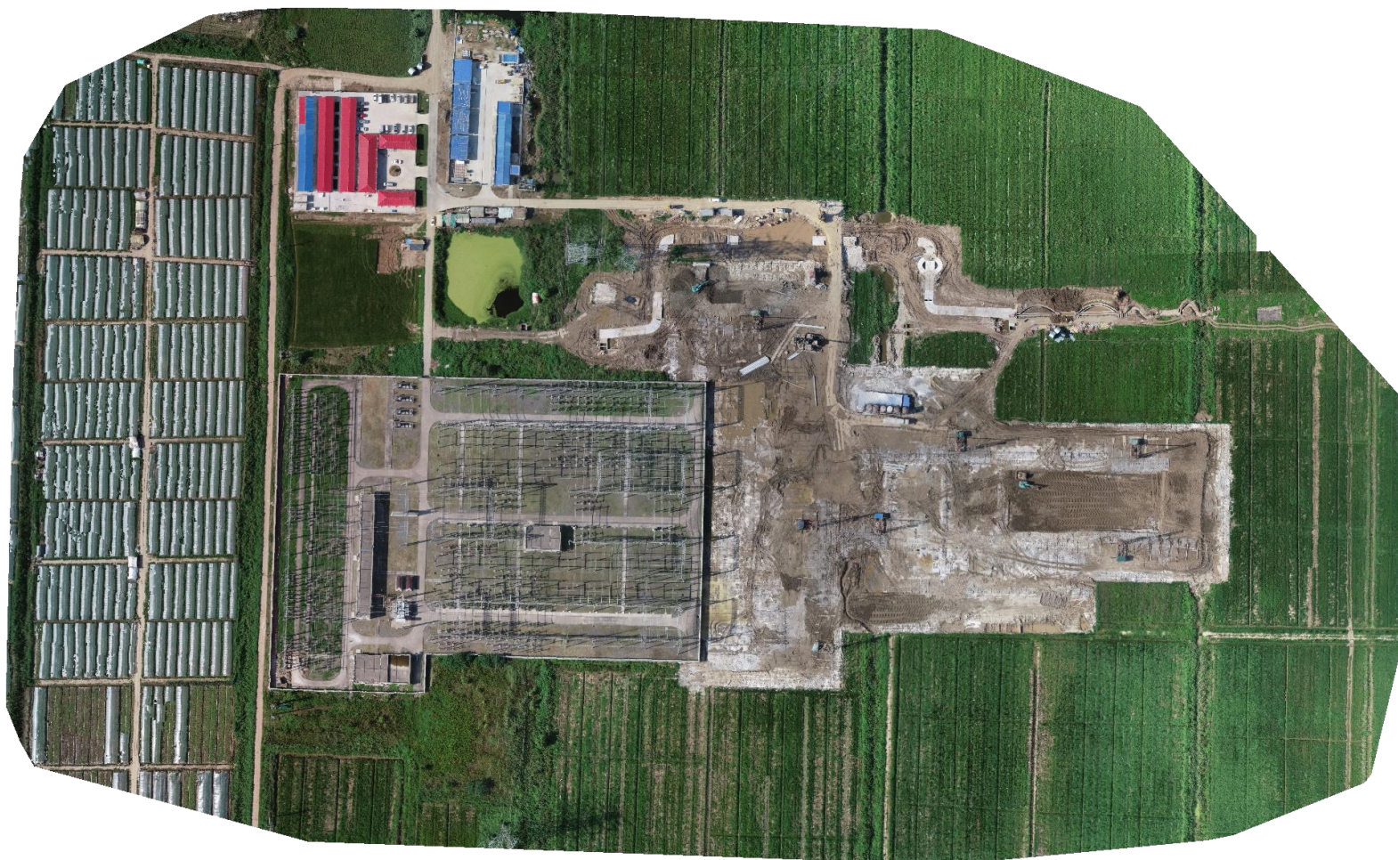
2018年8月（无人机高清航片，基础开挖阶段）
