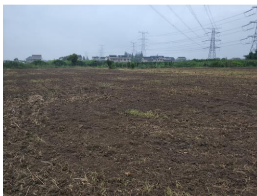
施工生产生活区表土剥离 (2018.7)
