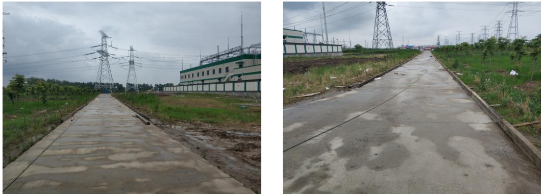
进站道路区撒播草籽（2019年8-9月）
