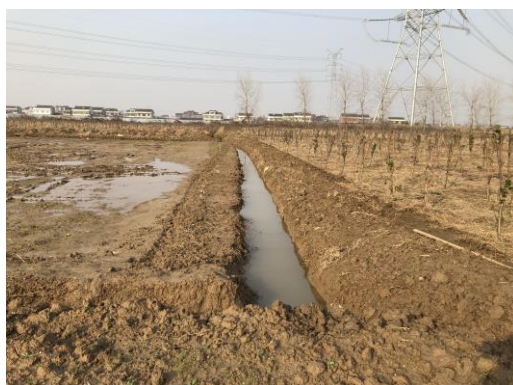
塔基区临时土质排水沟
