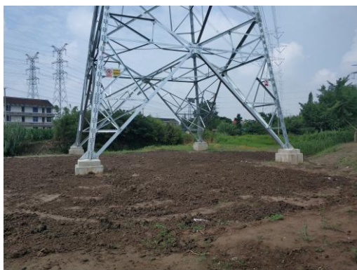
塔基区土地整治 (2019.7)
