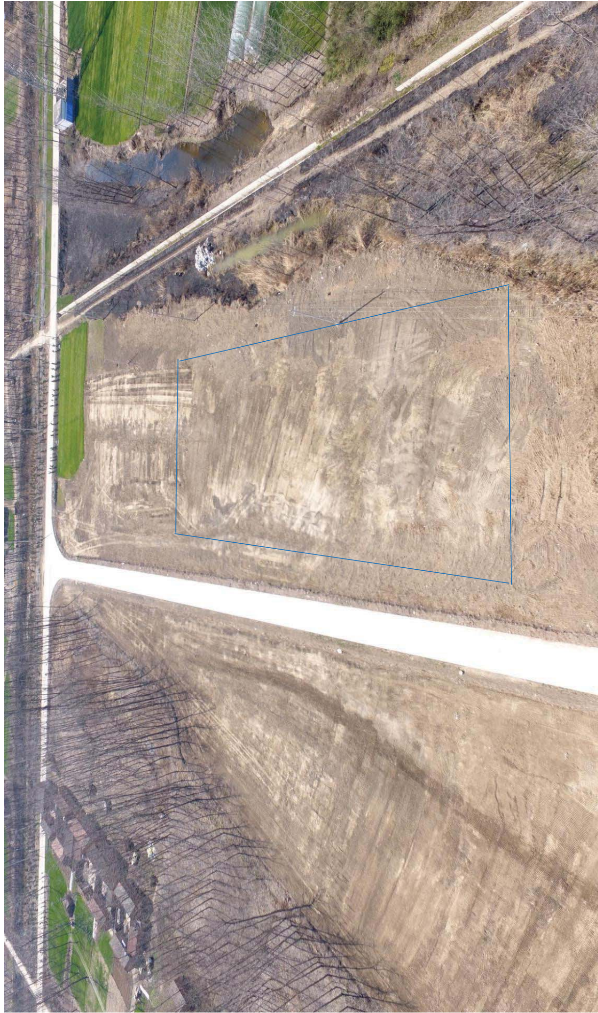
2018年12月23日（建设后） 施工生活区及进站道路区
