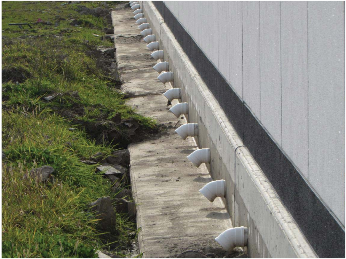
图 3 站区混凝土挡土墙
