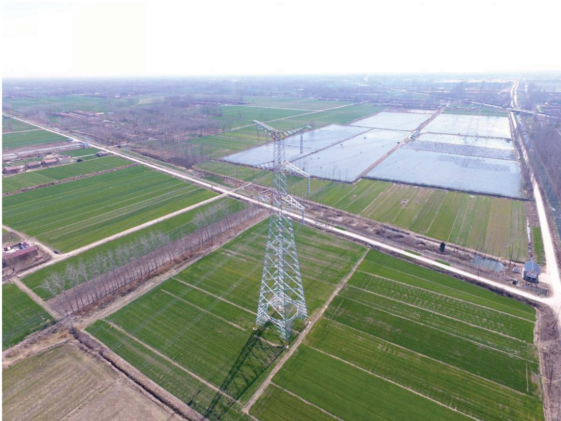
图 6 塔基区土地整治* (NG8)
