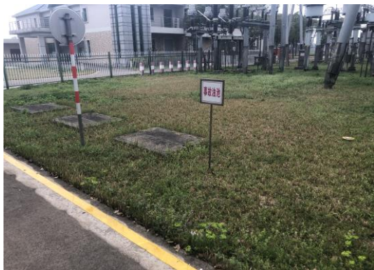
现有事故油池
