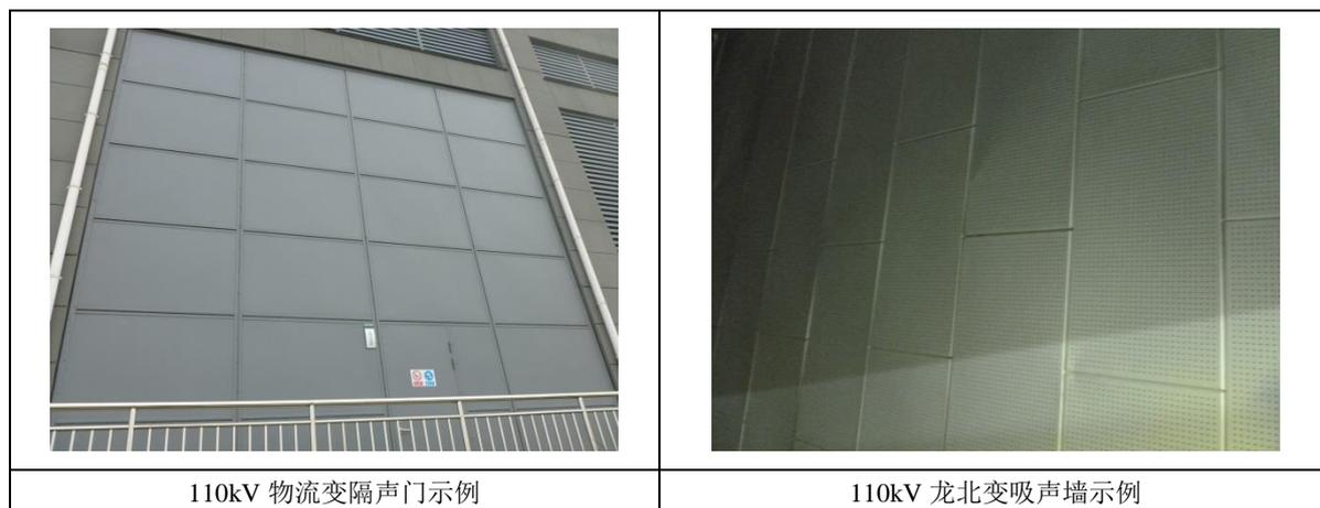
图 6-2 户内型变电站隔声措施示例
