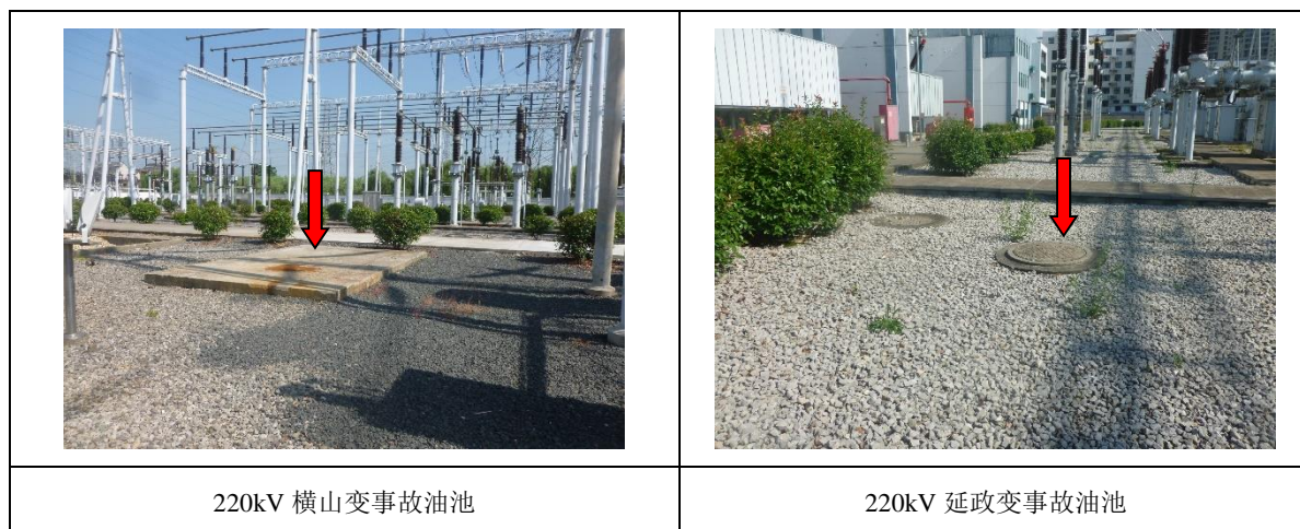
图 6-2 各变电站事故油池
